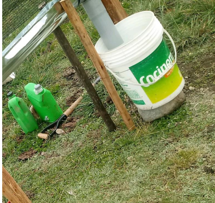
Figura 10. Codo PVC conectado con una tubería, los cuales conducirán el agua captada hacia el balde.
