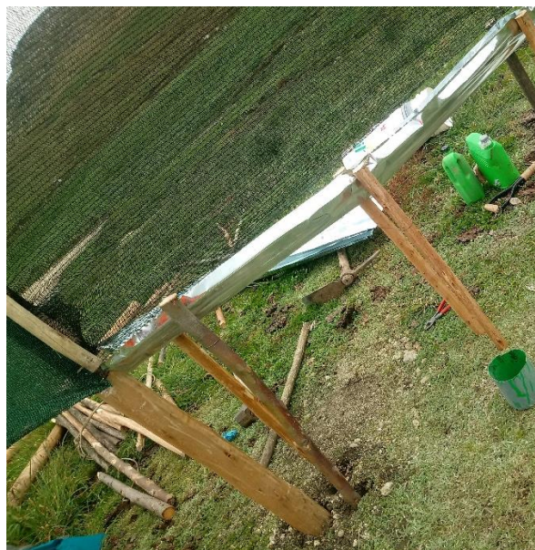
Figura 9. Estacas colocadas, sujetando la calamina que cumplirá la función de conducir el agua captada hacia el recipiente.
