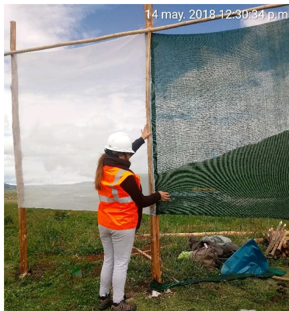
Figura 7. Colocación de la varita en los extremos de cada malla, siendo clavada sobre cada malla y el poste, para asegurar la estabilidad.
