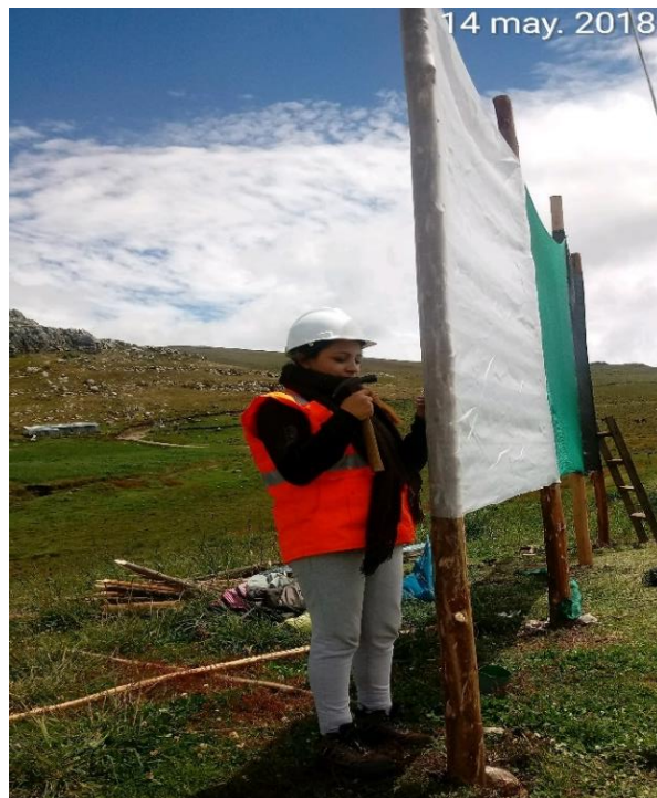
Figura 5. Clavando los extremos de la malla una vez templadas.
