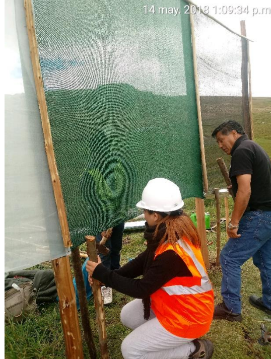
Figura 8 Clavando las estacas, las cuales irán entre cada poste sujetando la canaleta que será de calamina.
