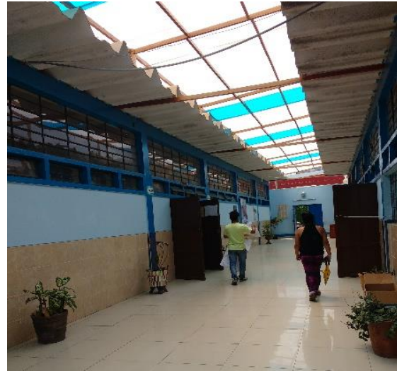
Figura N°10. Bloque “A4” de la I.E. Liceo Trujillo
