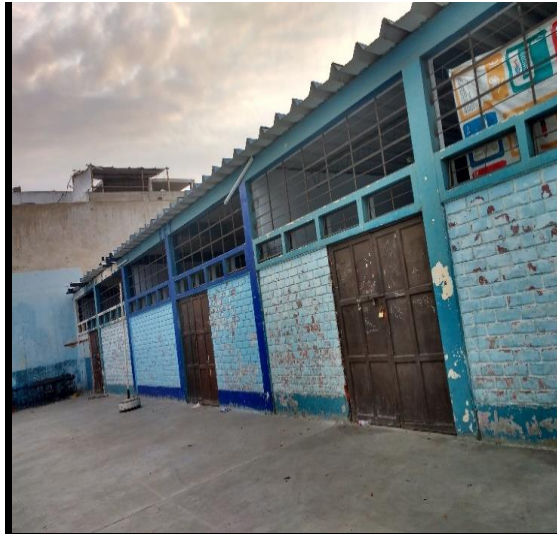
Figura N°13. Bloque “A8” de la I.E. Liceo Trujillo
