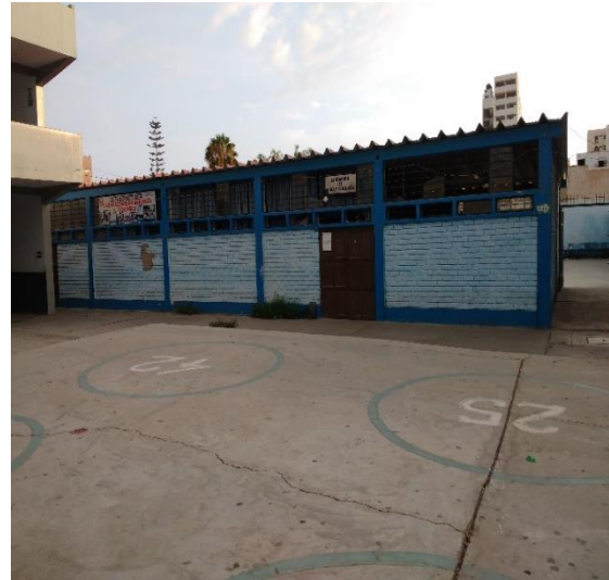
Figura N°12. Bloque “A7” de la I.E. Liceo Trujillo
