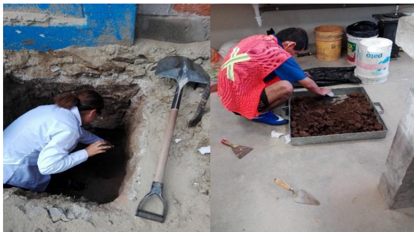
Figura. N°51. Realizando Excavación de Calicata.
