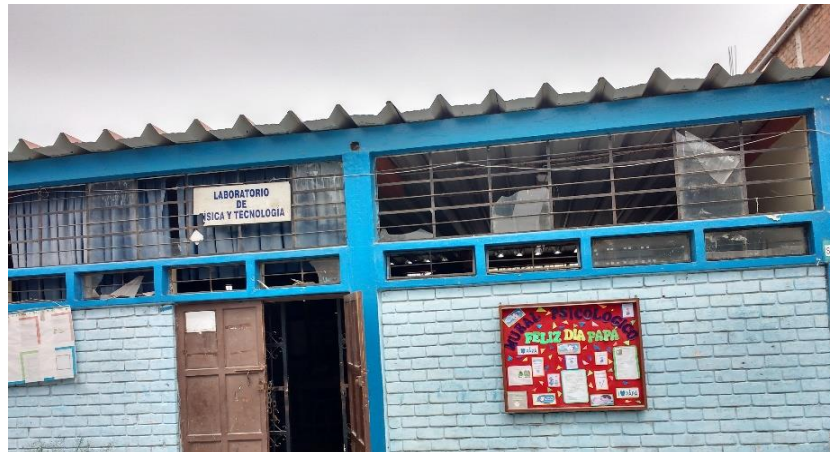
Figura N°32. Cubiertas de la I.E. Liceo Trujillo
