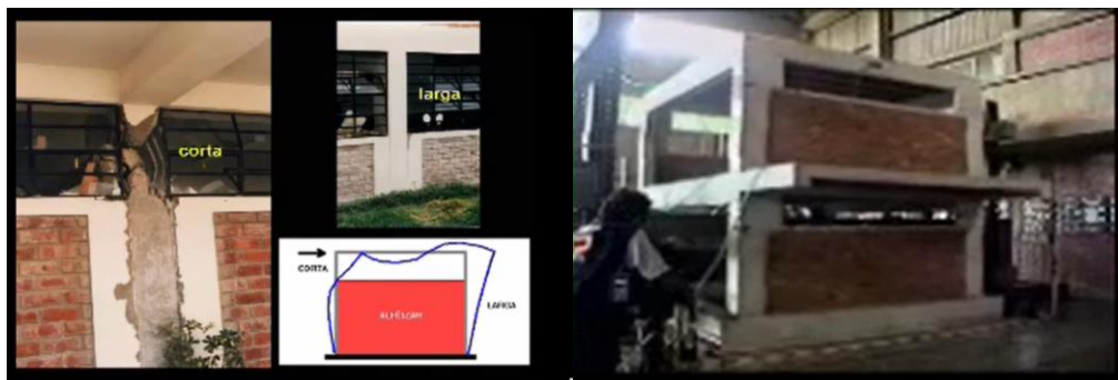
Figura N°45. Columnas cortas con ensanche
