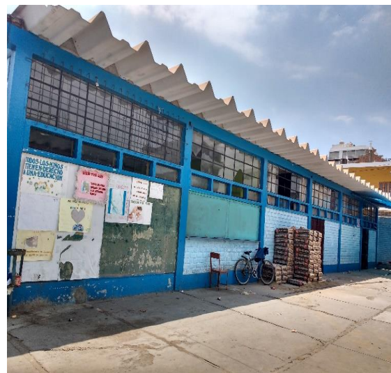
Figura N°08. Bloque “A2” de la I.E. Liceo Trujillo
