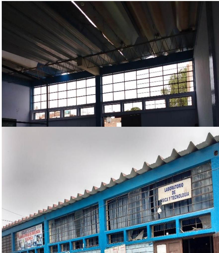
Figura N°33. Bloques de la I.E. I.E. Liceo Trujillo
