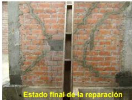
Figura N°43. Estado final de reparación
