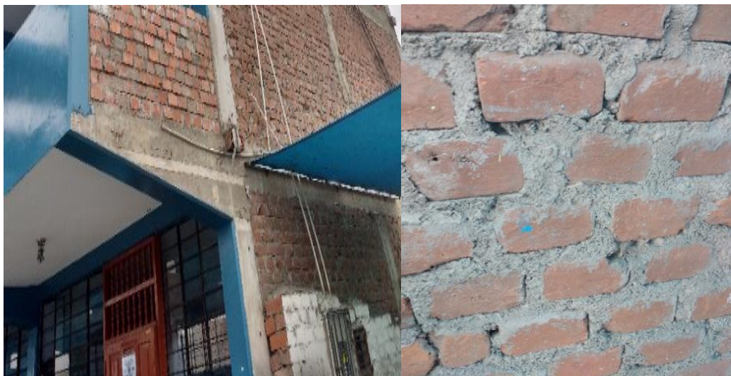
Figura N°14. Muros de albañilería de la I.E. Liceo Trujillo
