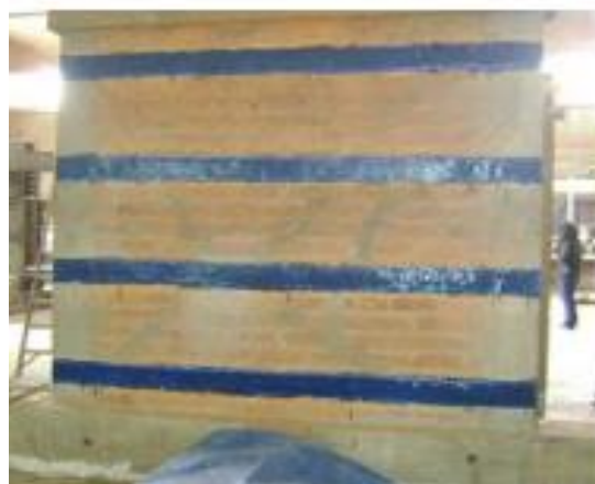
Figura N°44. Reparación de muro
