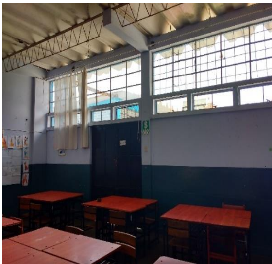
Figura N°07. Bloque “A1” de la I.E. Liceo Trujillo
