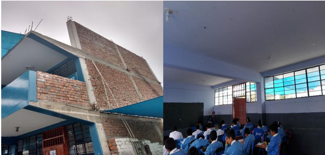
Figura N°06. Bloque “B3” Liceo Trujillo
