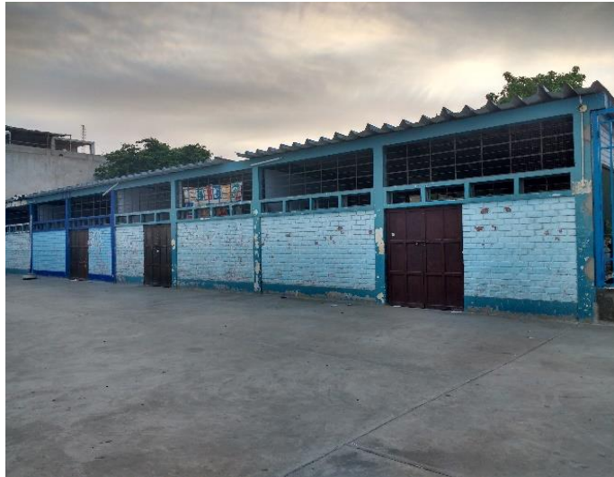
Figura N°16. Bloques “A8” de la I.E. Liceo Trujillo
