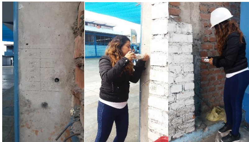
Figura. N°54. Realizando ensayo de Esclerometría.
