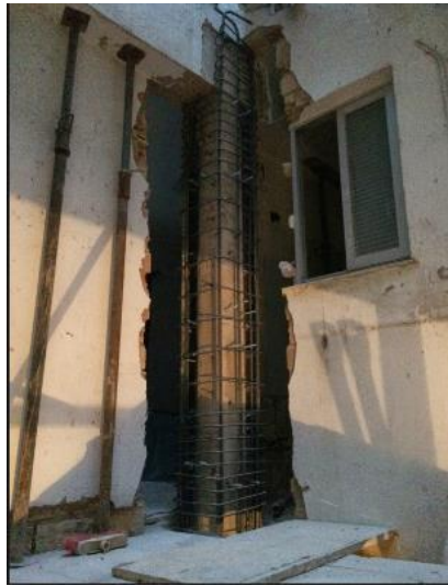
Figura N°46. Estado final de reparación
