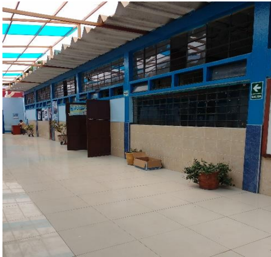
Figura N°09. Bloque “A3” de la I.E. Liceo Trujillo
