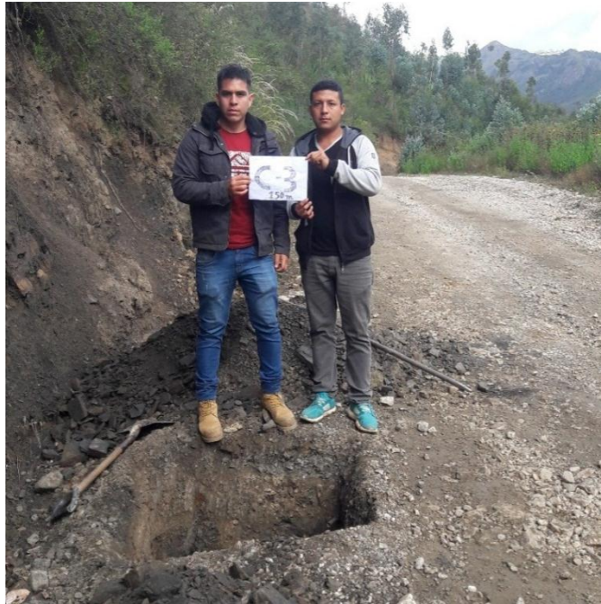
Figura 89: Calicata N° 3 Tramo +2.00 Km - +3.00 Km (Propia)
