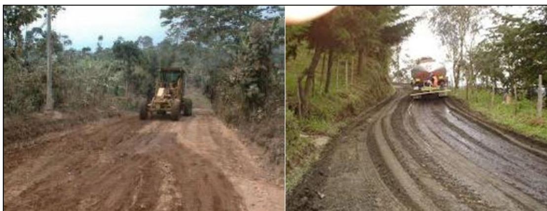
Figura 7: Base estabilizada con emulsión asfáltica. (Tecnología de pavimentos, 2010)
