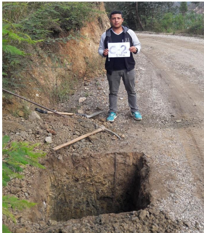
Figura 88: Calicata N° 2 Tramo +1.00 Km - +2.00 Km (Propia)
