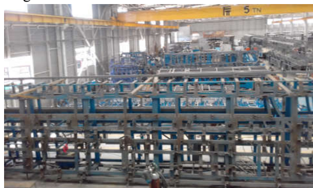
Imagen N° 4: Área de Habilitado de Estructuras
