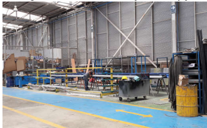
Imagen N° 13: Area Habilitado pasamanos y puertas
