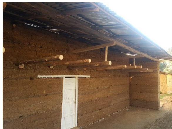
Corrección de muros, retoque con barro, mejora de la viga de soporte, interiormente se puso viga de bajo de la viga de arriostre para que el ancho del muro cumpla la norma.
