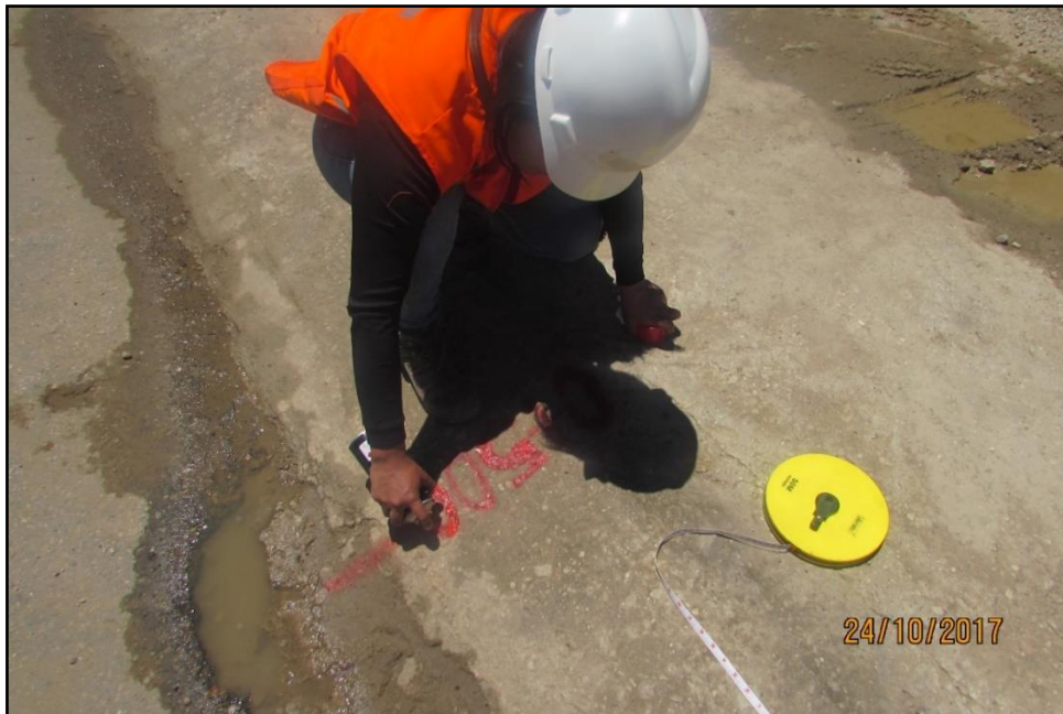
FIGURA N° 32: Progresiva km 000 + 500 m.
