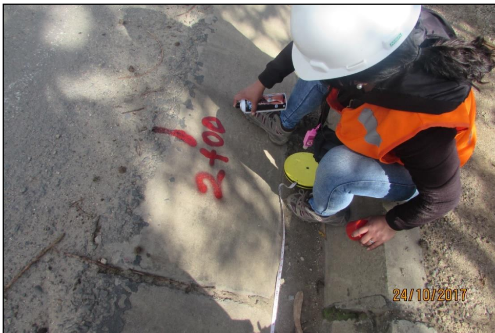
FIGURA N° 35: Progresiva km 002 + 000 m.
