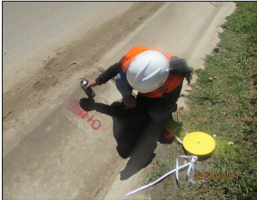
FIGURA N° 30: Colocación de las progresivas km 000+050 m
