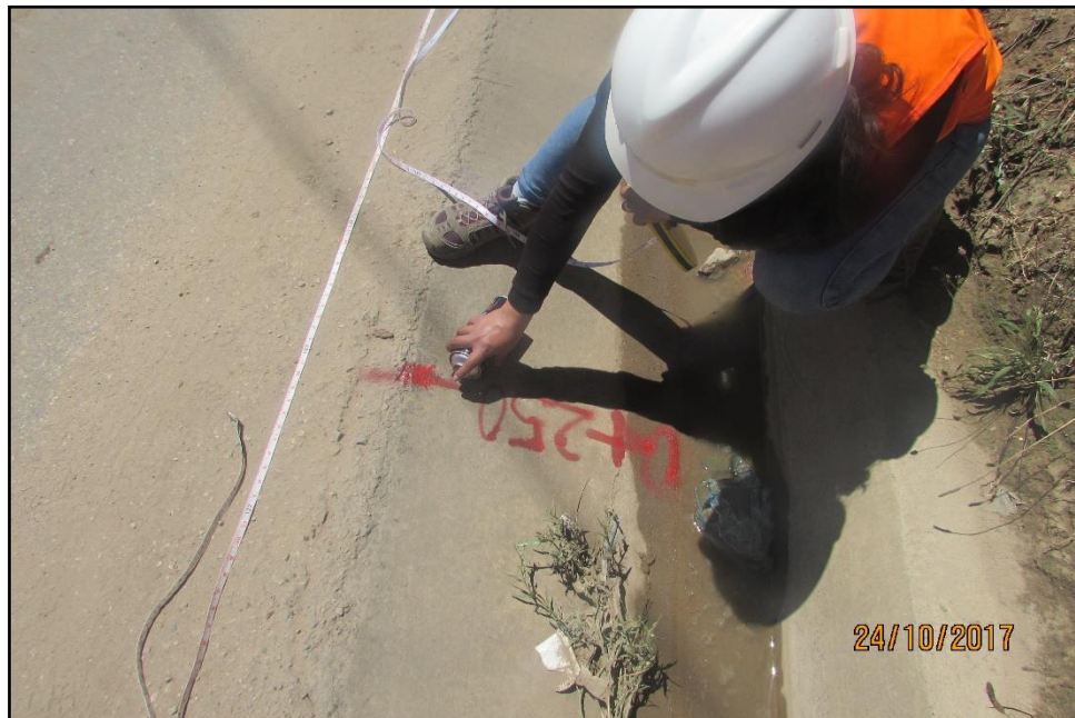
FIGURA N° 31: Colocación de las progresivas km 000+250 m
