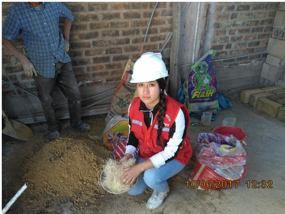
Imagen 35. Elaboración de adobes compactados con adición de fibra de maguey.
