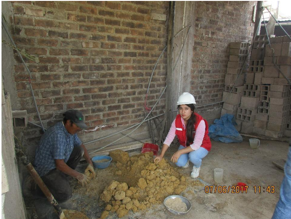
Imagen 32. Mezcla de material con proporciones de agua para la realización de adobes.
