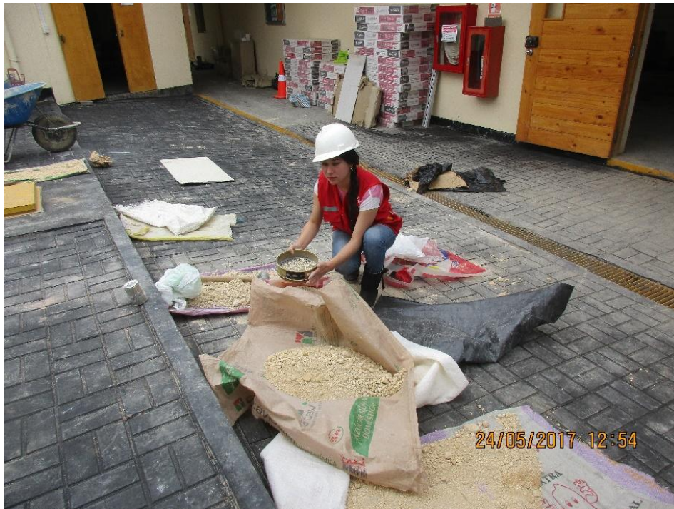
Imagen 25. Tamizado de material para la elaboración del ensayo de Proctor modificado.
