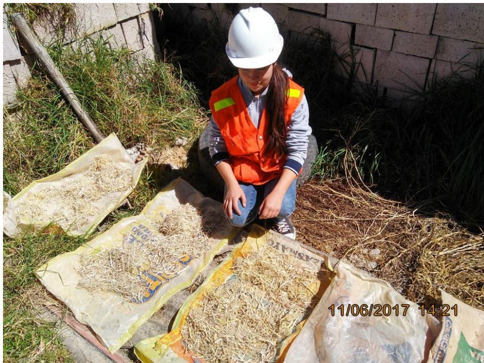
Imagen 37. Fibra de maguey cortada para ser incorporada a los adobes.
