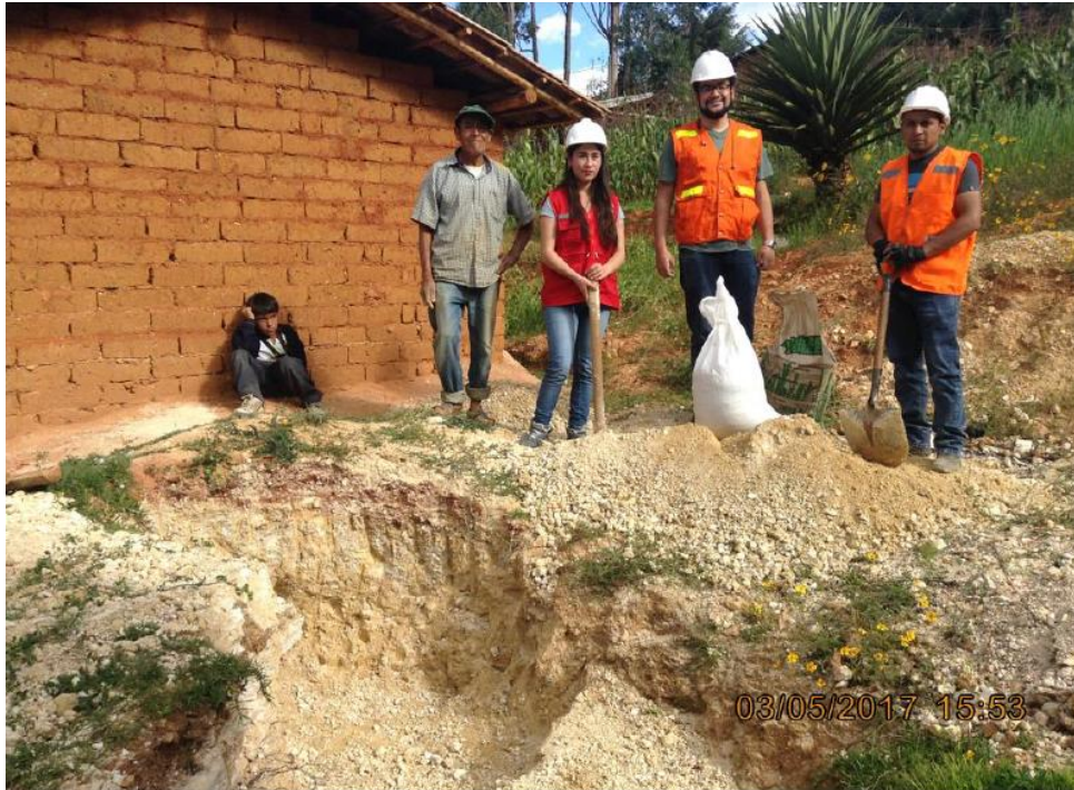
Imagen 9. Extracción de material de la calicata habilitada en la cantera.
