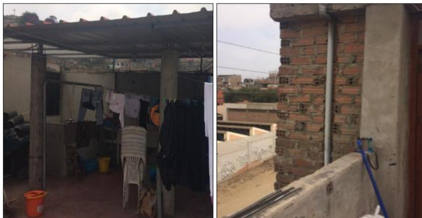
**Figura N° 90:** Cobertura inestable y muros de tabiquería sin confinamiento de la vivienda N°6.
