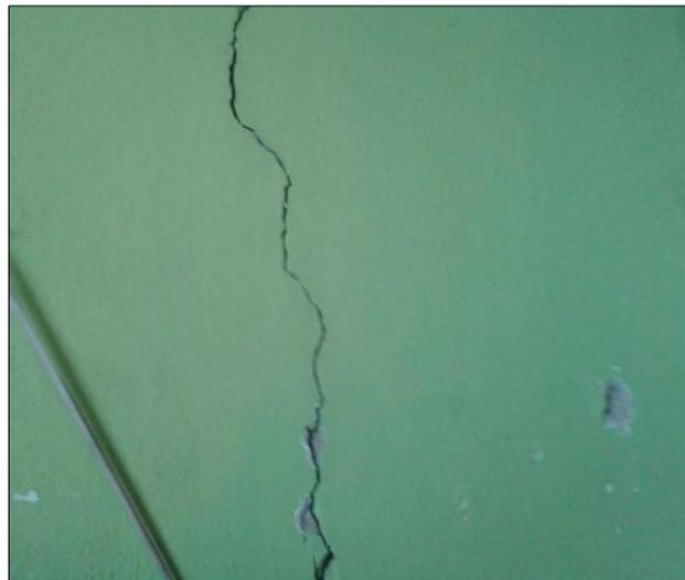
**Figura N° 53:** Muros con fisuras entre 2 a 3 milímetros.
