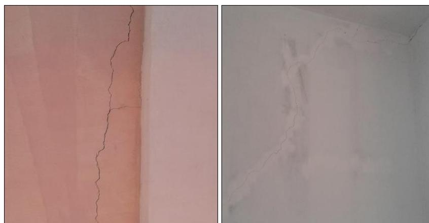
**Figura N° 102:** Muros con fisuras por toda la vivienda N°10.
