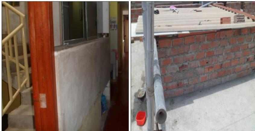
**Figura N° 99:** Parapetos sin confinamiento y coberturas inestables en la vivienda N°9.
