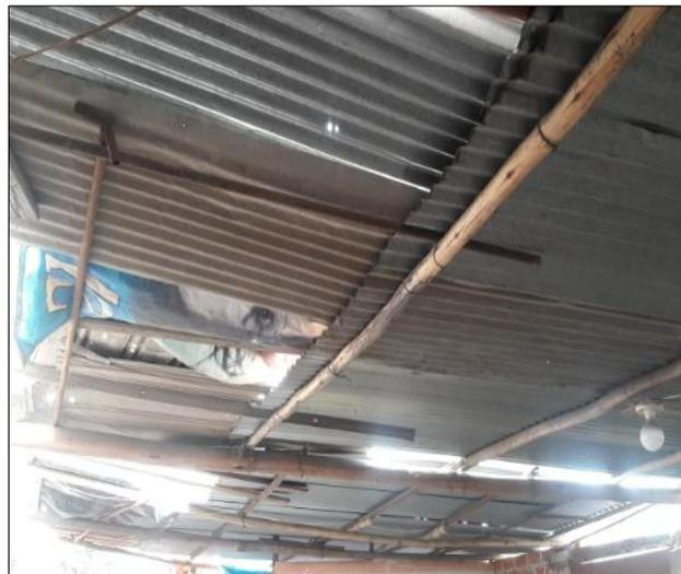
**Figura N° 47:** Separación de vigas y arriostramiento de las mismas.
