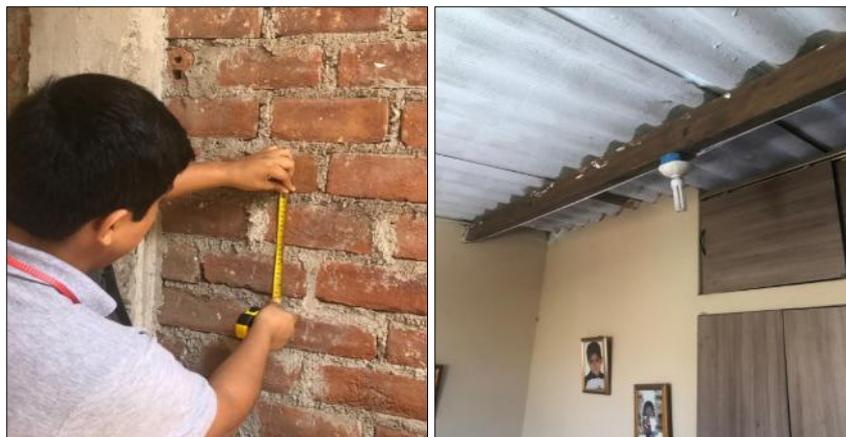
**Figura N° 96:** Muros con ladrillo artesanal y cobertura de fibrocemento en la vivienda N°8.
