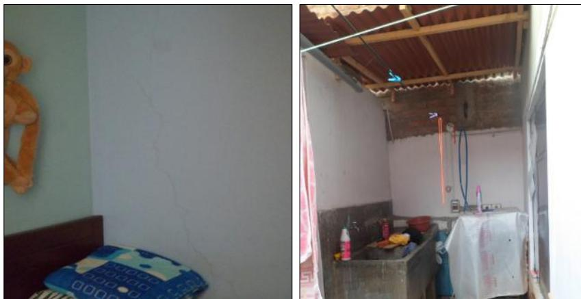
**Figura N° 84:** Muros con fisuras y coberturas inestables en la vivienda N°4.
