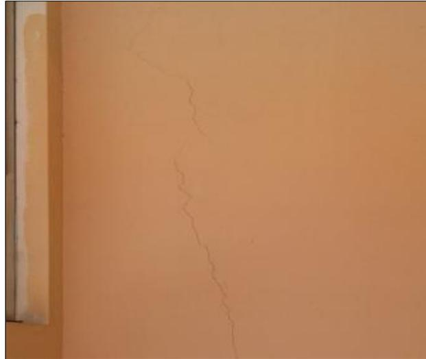
**Figura N° 52:** Muros con fisuras menores a 2 milímetros.
