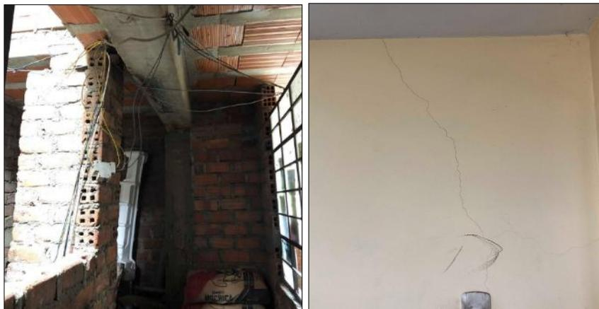
**Figura N° 117:** Muros de tabiquería sin confinamiento y fisuras en las paredes de la vivienda N°15.
