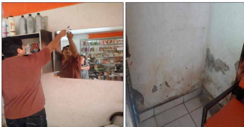
**Figura N° 81:** Muros con fisuras y presencia de humedad en la vivienda N°3.
