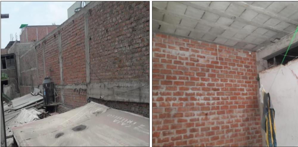
**Figura N° 15:** Viviendas del sector Central Barrio 1 y 2 con sistema estructural de albañilería.
