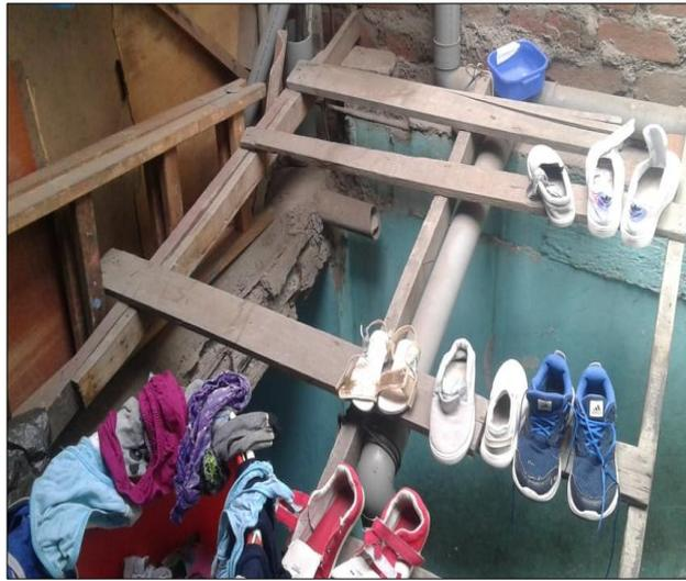
**Figura N° 50:** Elementos inestables mal conectados a la estructura.
