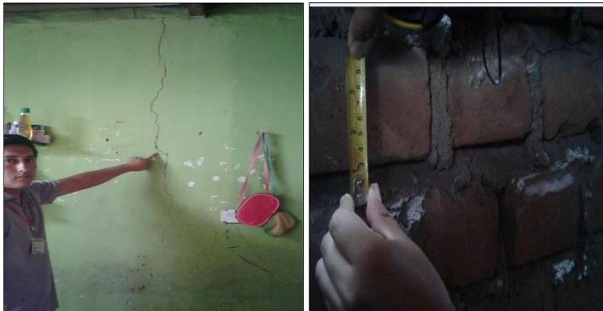
**Figura N° 105:** Muros con fisuras, con ladrillos artesanales y espesores de mortero mayores a 1.5 cm en la vivienda N°11.
