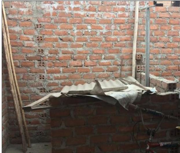
**Figura N° 26:** Muros de ladrillo artesanal.
