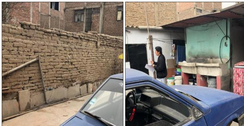
**Figura N° 114:** Muro de adobe no confinado y coberturas inestables en la vivienda N°14.
