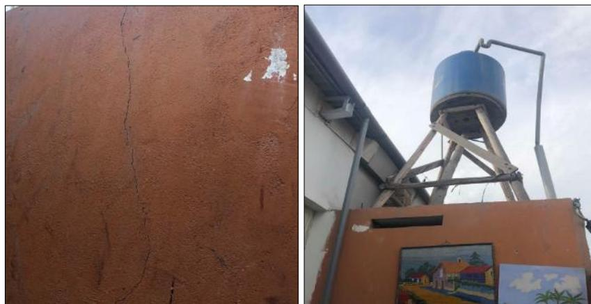
**Figura N° 87:** Muros con fisuras y un tanque elevado sin un anclaje correcto en la vivienda N°5.
