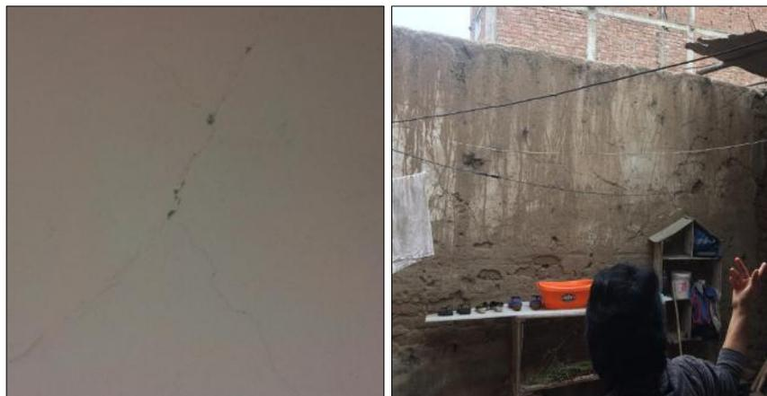
**Figura N° 75:** Muros con fisuras y un muro de adobe no confinado en la parte posterior de la vivienda N°1.
