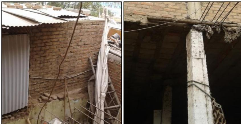
**Figura N° 120:** Muros sin confinamiento y problemas de piso blando en la vivienda N°16.
