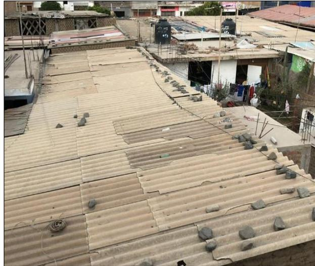
**Figura N° 46:** Cubiertas inestables, que no garantizan un comportamiento de diafragma rígido.
