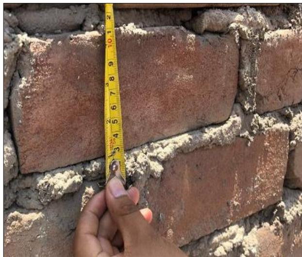
**Figura N° 27:** Muros con espesor de junta entre 2 a 3 centímetros.
