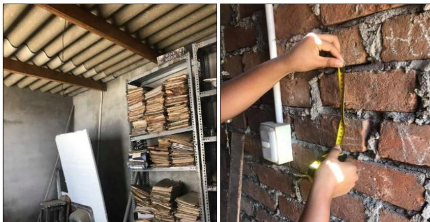
**Figura N° 108:** Coberturas de fibrocemento, muros con ladrillos artesanales y espesores de mortero mayores a 1.5 cm en la vivienda N°12.
