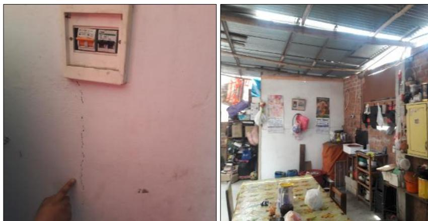
**Figura N° 78:** Muros con fisuras y coberturas inestables de la vivienda N°2.
