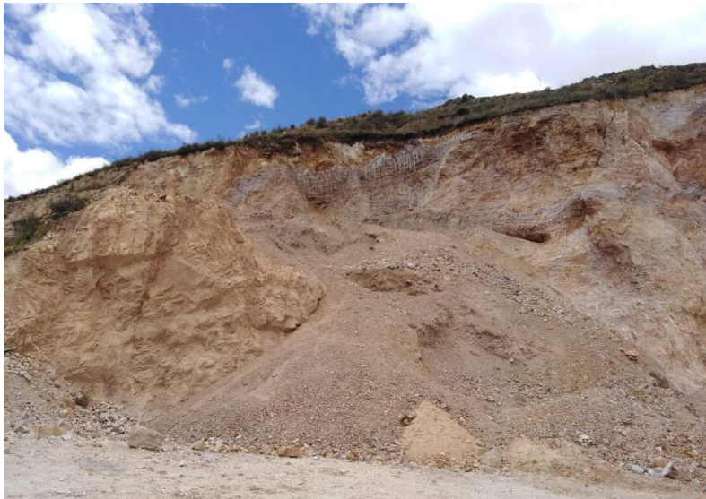
Fig. 33: El eje de la excavación es perpendicular a la dirección de los estratos, zona 3.
