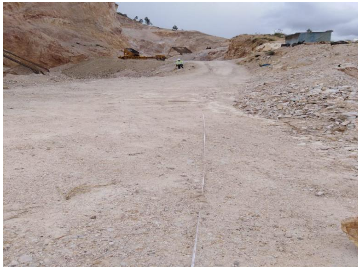
Fig. 41: Plataforma de trabajo 60 m.
