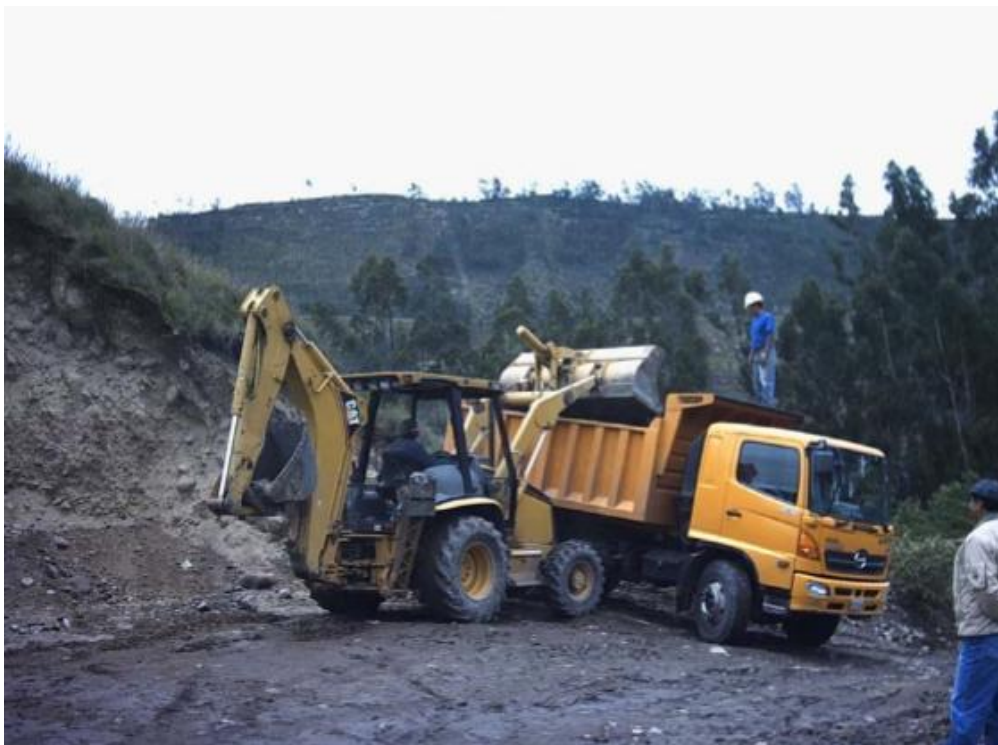
Fig. 48: Carguío y Transporte de material en la Cantera Agocucho
