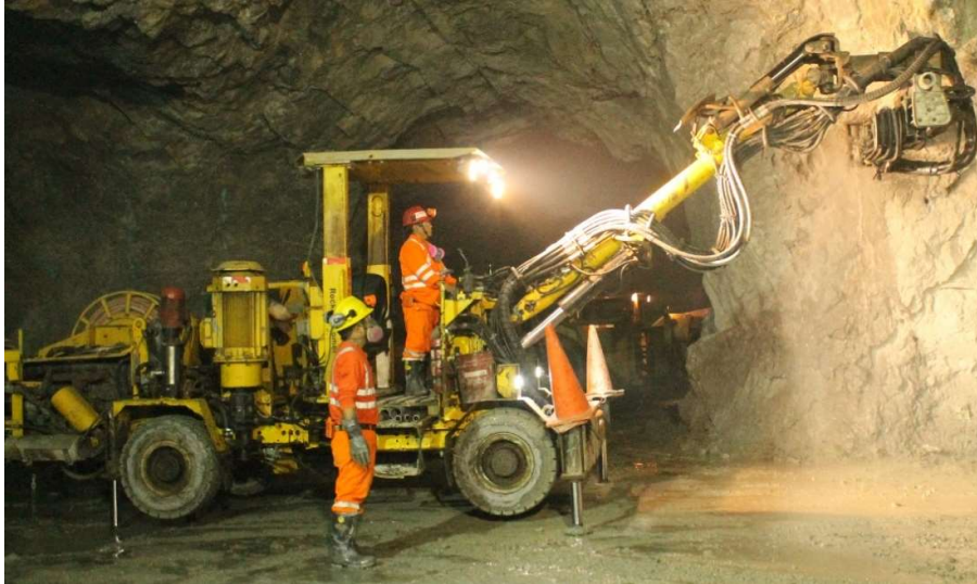
Figura N° 13. Equipo de Perforación de Taladros largos en pleno trabajo
