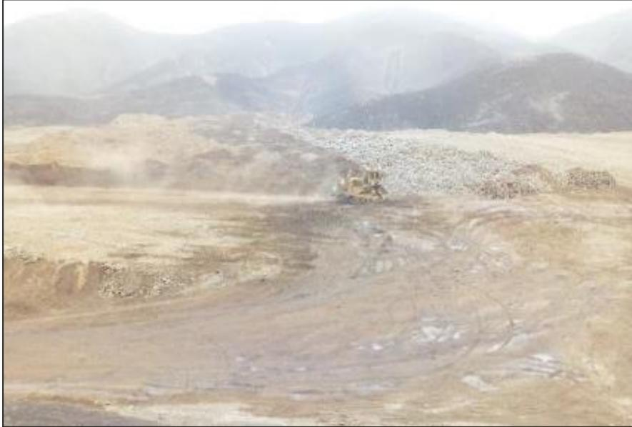
**Figura 44.** *Conformación del botadero 1/3*
