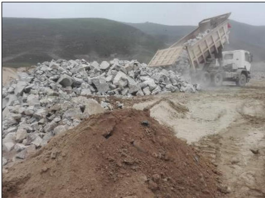
**Figura 41.** Descarga de material de voladura (2/4)
