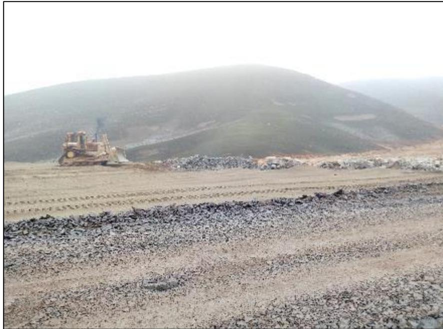
**Figura 46.** *Conformación del botadero 3/3.*
