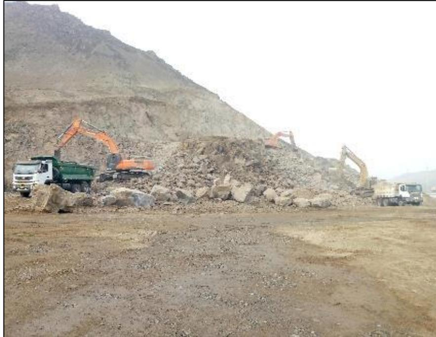
**Figura 36.** Eliminación de material de voladura 1/4
