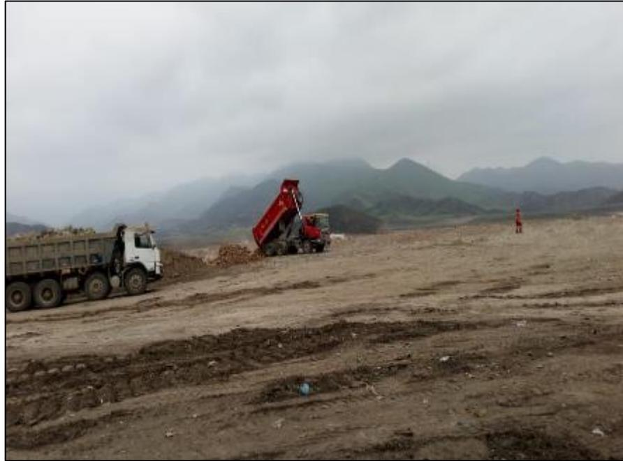
**Figura 40.** Descarga de material de voladura (1/4)
