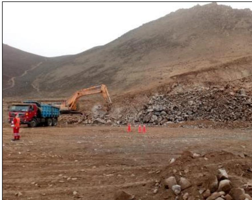
**Figura 37.** Eliminación de material de voladura 2/4
