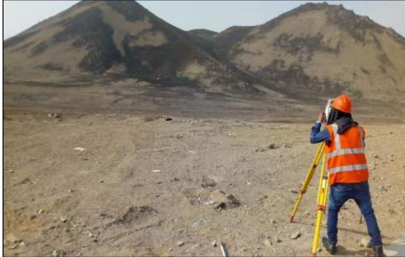
**Figura 32.** Levantamiento topográfico de los lotes
