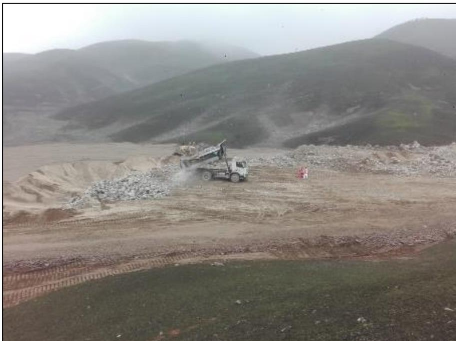
**Figura 43.** Descarga de material de voladura (4/4)
