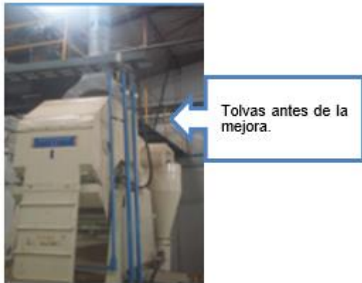
Figura III.38 Tolva de cargadora grano de cacao antes de la mejora
