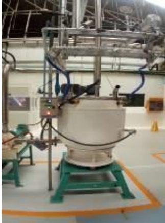
Figura III.17 Proceso inicial de precargado
