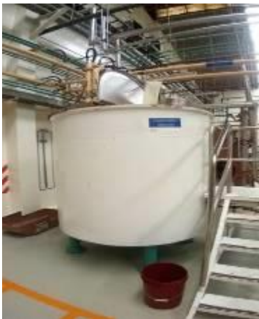
Figura III.19 Proceso de decantado
