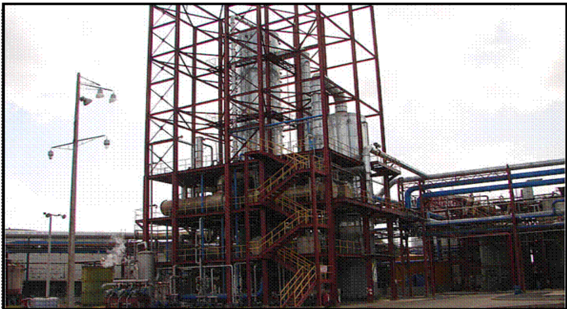
Figura 72 Columnas de destilación de etanol 96 °GL (% v/v) Fuente: Bioenergía SAC.
