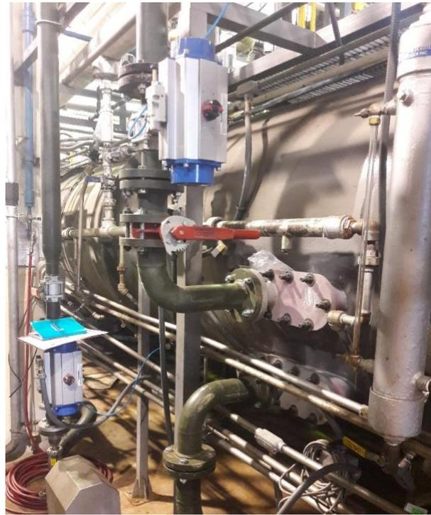
*Figura 45.* Válvula On/off en tubo de precalentamiento.
