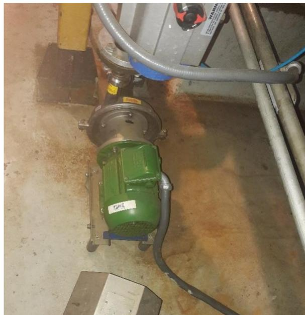
*Figura 46.* Bomba centrífuga de recirculación de agua en tubo de precalentamiento.
