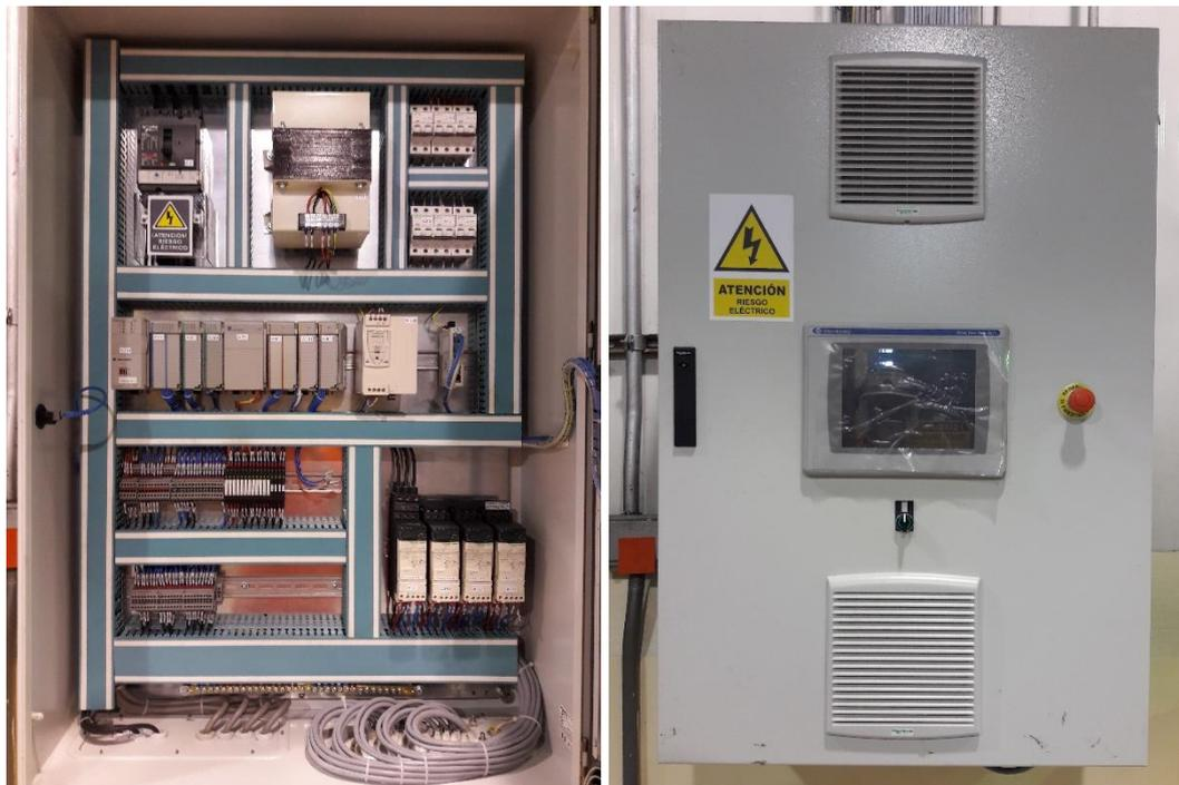
*Figura 23:* Vista interior y exterior del tablero de control y fuerza del HRS.
