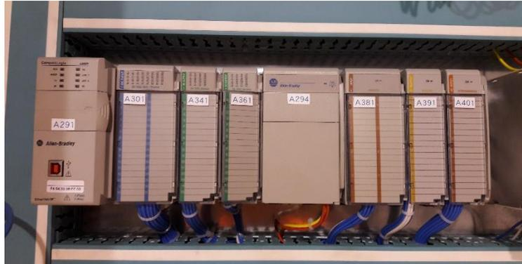
*Figura 25:* Controlador lógico CompactLogix L33ER.
