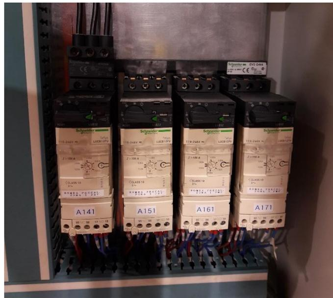
Figura 34. Arrancadores Tesys U con esquema de conexión
