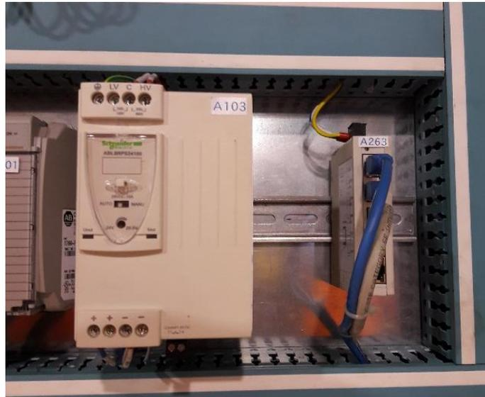
*Figura 32:* Fuente de alimentación 24VDC y Switch Ethernet IP.
