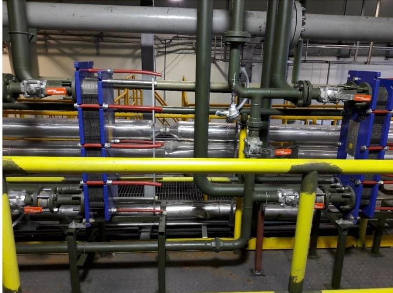
*Figura 43.* Intercambiadores de placas del HRS instalados.
