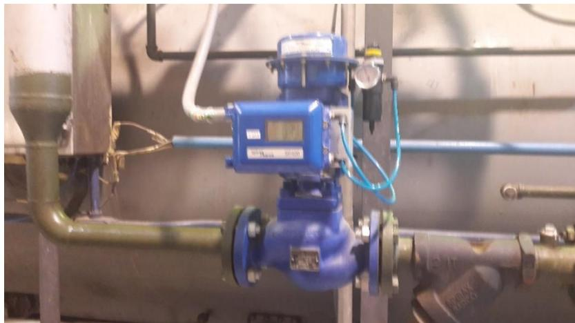
*Figura 44.* Válvula de control Salida de agua en Tubo de Enfriamiento.
