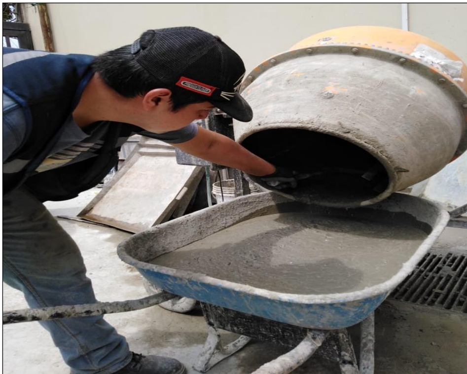
Figura N° 30 Elaboracion del concreto en un trompo mezclador.
