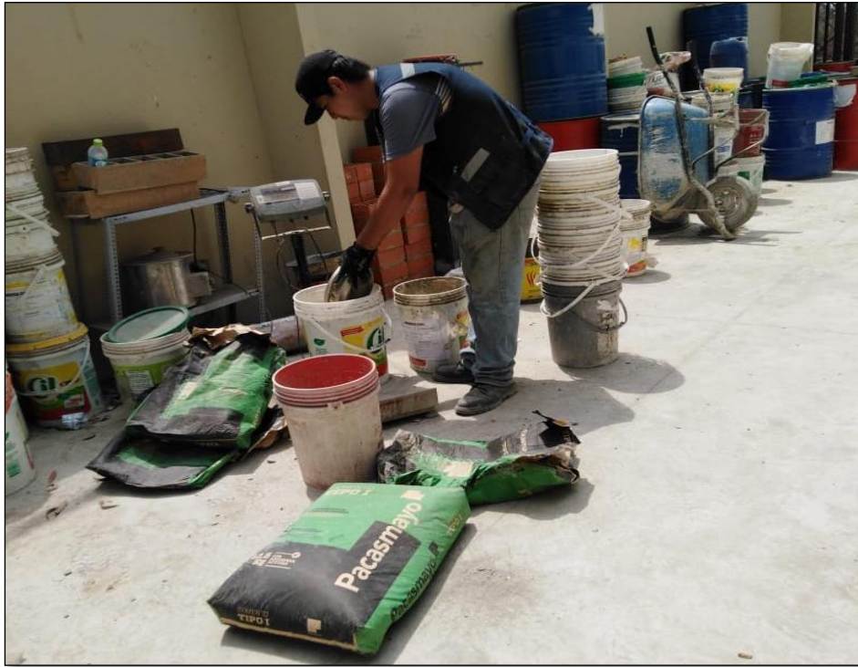
Figura N° 29 Pesando los agregados para la elaboración del concreto.
