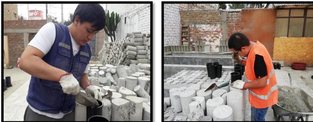
Figura N° 23 Vaciado de concreto a moldes de probetas de 4" x 8". Fuente: Propia.
