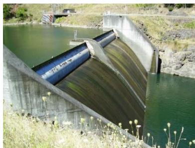
*Figura N° 5 Vertedero Hidráulico. Fuente: Vásquez, 2012*
