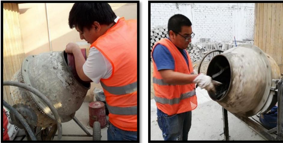
*Figura N° 19 Elaboración de Concreto. Fuente: Propia.*
