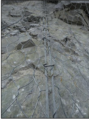
Colocación de Lap ling en empalme longitudinal de malla Steel Grid
