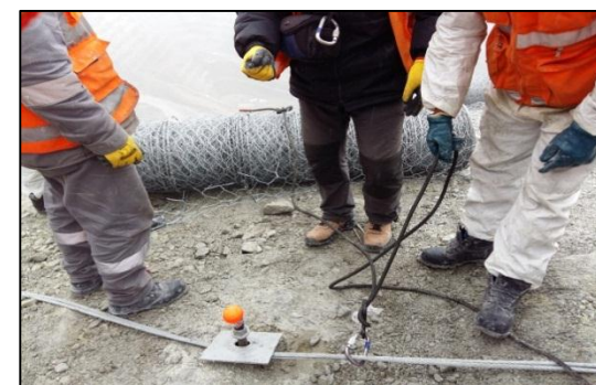
Instalación de cable para línea de vida
