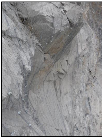
Malla Steel Grid, moldeada al relieve de la roca por los pernos expansivos colocados
