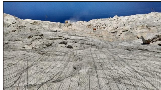
Tendido de Malla Steel Grid
