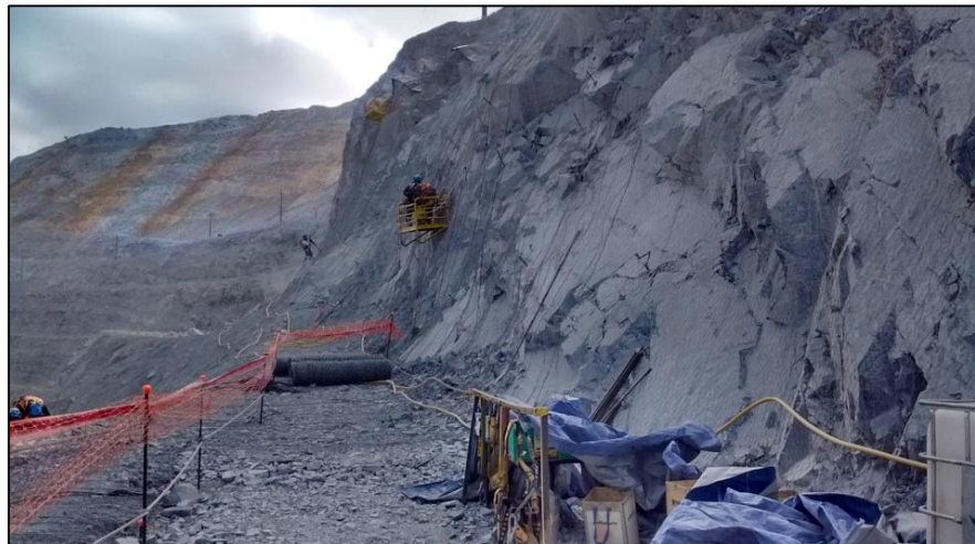
Inicio de Perforación de pernos de anclajes de 3.00 m entre la cresta y primera banqueta.
