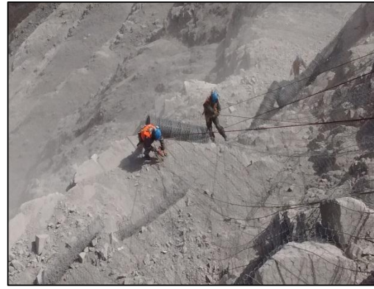
Descenso en talud de malla Steel Grid
