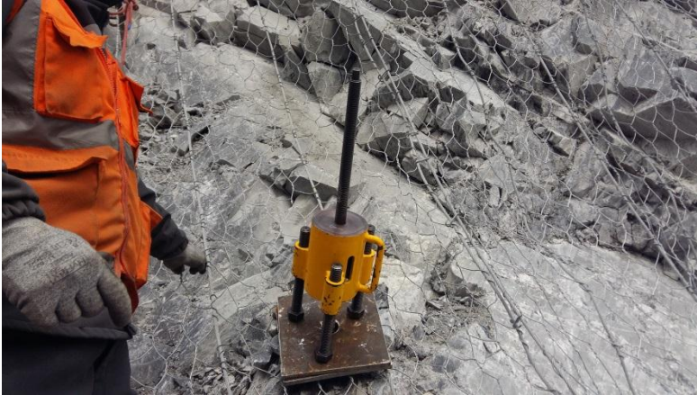
INSTALACIÓN DE CASTILLO
