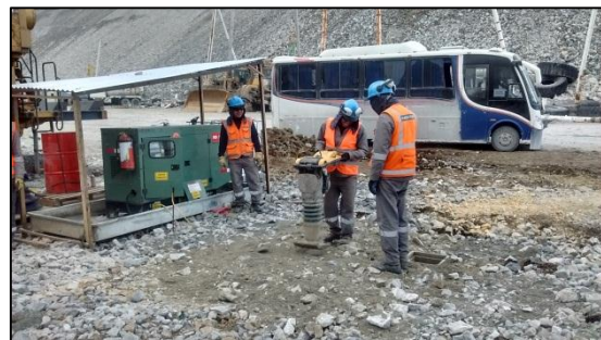
Rellenado de la excavación de puesta a tierra en almacén y oficinas Maccaferri
