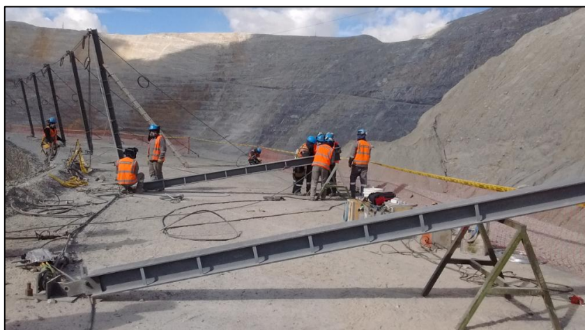
Desmontaje de Barrera Dinámica en Chancadora Primaria
