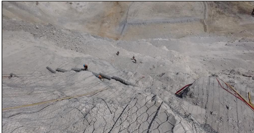
Trabajos de instalación de mallas
