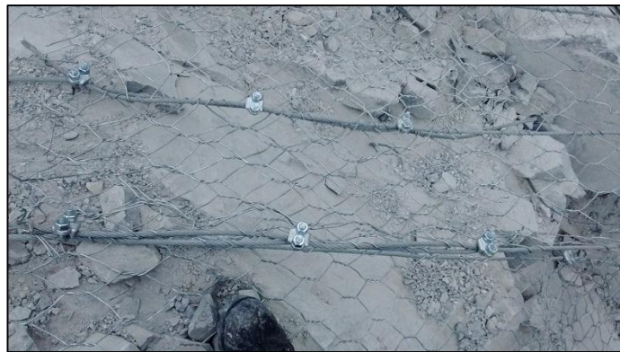
Colocación de grapas de 3/8” en el empalme de las mallas de Steel Grid
