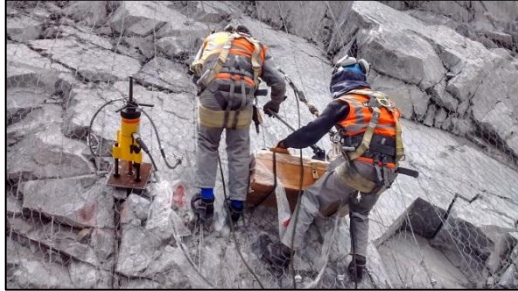
Realizando pruebas de Pull Test a los pernos de anclaje colocados en talud
