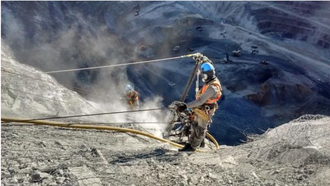
PERFORACIÓN DEL SEGUNDO TALADRO DE 6.00 MTS DE PROFUNDIDAD
