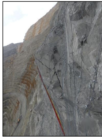
Disposición final de la malla colocada con los traslapes entre mallas con grapas de 3/8”
