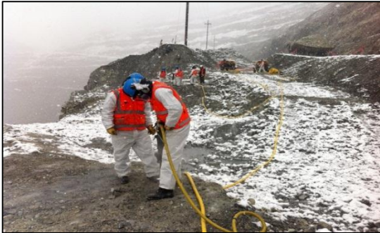
Perforación de pernos de corona
