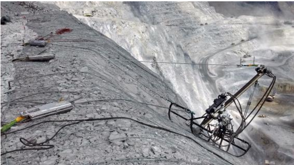
EQUIPO LISTO Y POSICIONADO PARA INICIAR PERFORACIÓN
