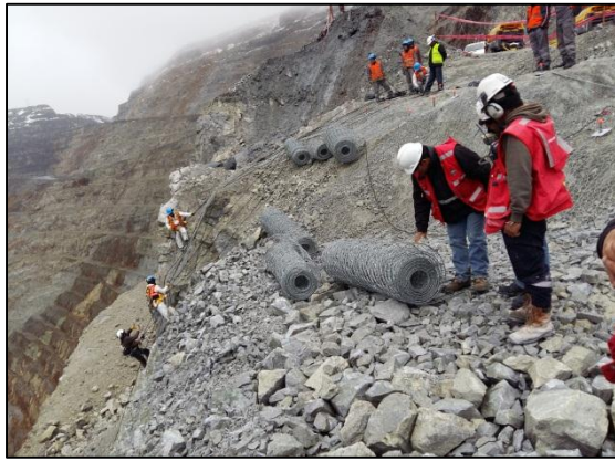
Descenso de personal en talud
