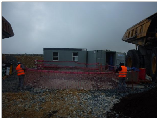
Excavación de zanjas y poza para el aterramiento de nuestro almacén y oficina
