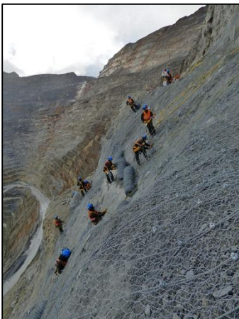
Tendido de Malla Steel Grid en talud
