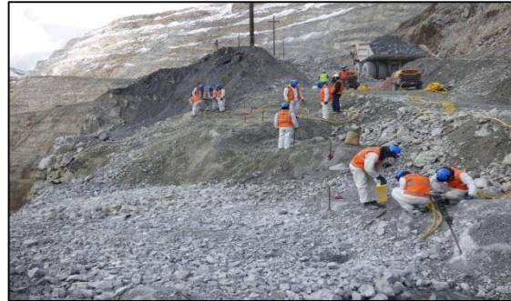
Colocación de pernos de corona
