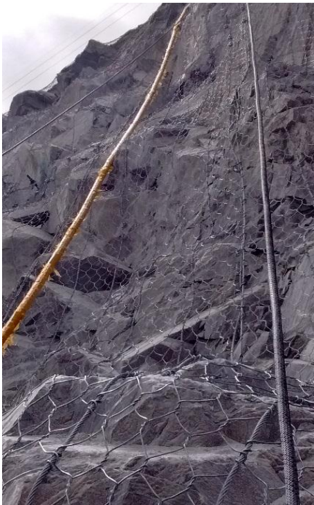
(Talud Fase 5 norte con mallas StacGrid, obra terminada)
