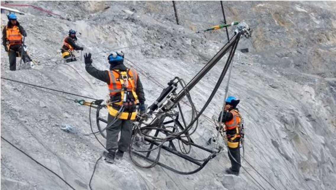
PERFORACIÓN DE TALADRO A 3.00 MTS DEL BORDE DE LA BANQUETA Y UNA PROFUNDIDAD DE 6.00 MTS
