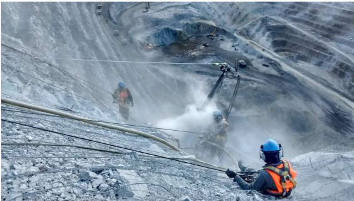
POLVO PRODUCTO DE LA PERFORACIÓN DEL SEGUNDO TALADRO
