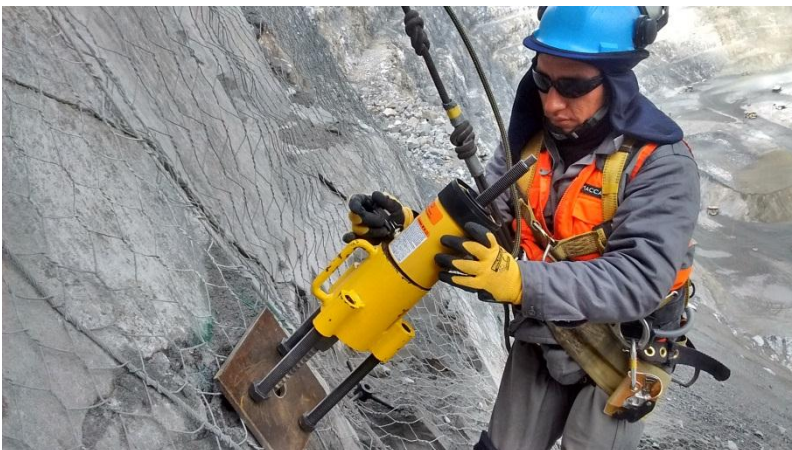
INSTALACIÓN DE MARIPOSA EN TIRANTE EXTRACTOR
