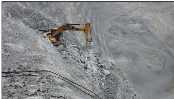
Limpieza de banqueta con apoyo de excavadora
