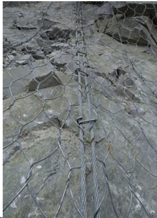
(Talud Fase 5 norte con mallas StacGrid, obra terminada)
