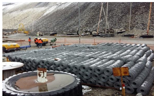
Suministro de malla Steel Grid y malla Galfan de trabajo
