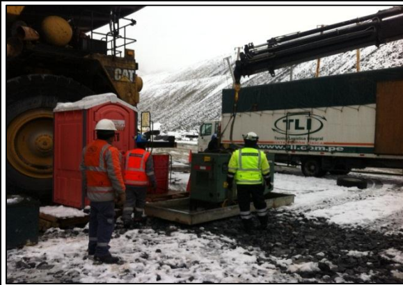
Descargando Generador para el suministro de energía para almacén y oficina
