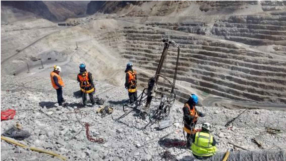
MINITRONER EN PRIMERA BANQUETA Y LISTO PARA INICIAR TRASLADO AL TALUD
