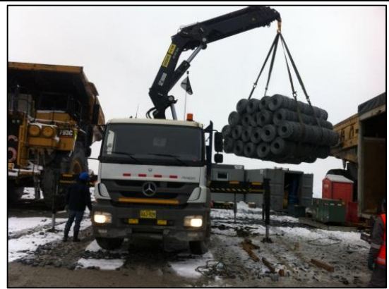
Descargando Mallas Steel Grid
