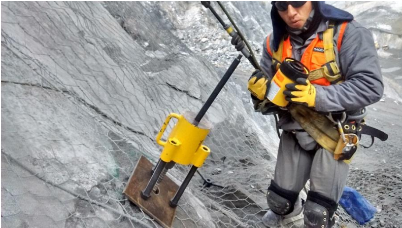
INSTALACIÓN DE PISTÓN
