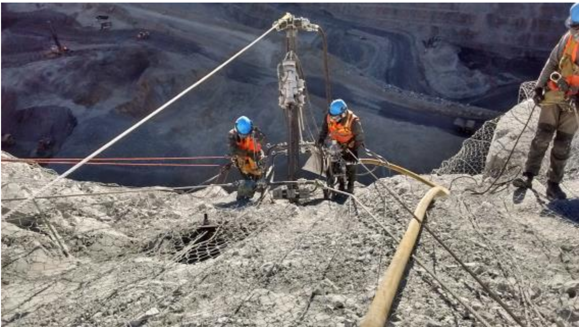
TRASLADO AL SIGUIENTE PUNTO DE PERFORACIÓN A 6.00 MTS DEL BORDE DE LA BANQUETA HACIA LA PARTE INFERIOR
