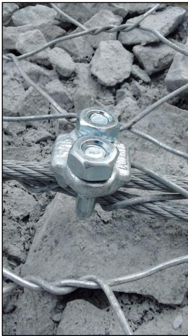
Colocación de grapas de 3/8” en el empalme de las mallas de Steel Grid
