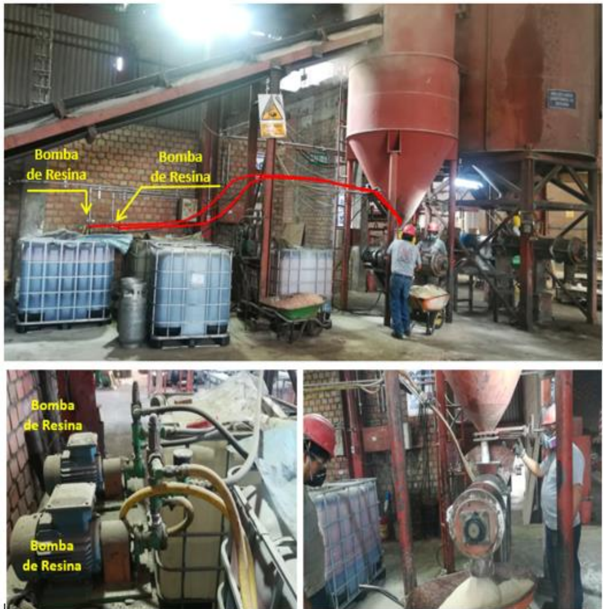
Figura 35. Sistema de bombeo de resina y catalizador sobre arena implementada
