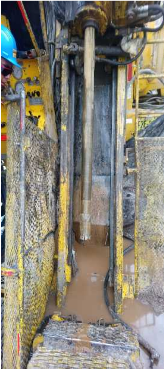
Ilustración 6: Broca diamantina de perforación en Antapaccay
