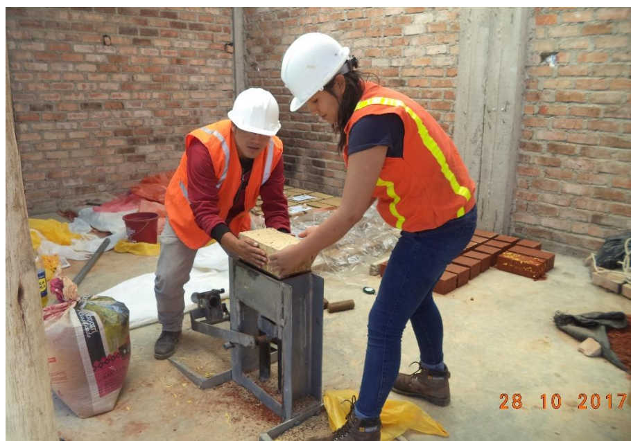
Figura N° 25: Elaboración del adobe compactado
