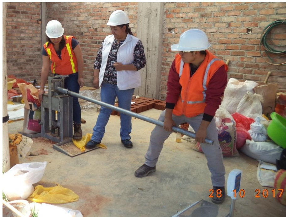
Figura N° 24: Elaboración del adobe compactado
