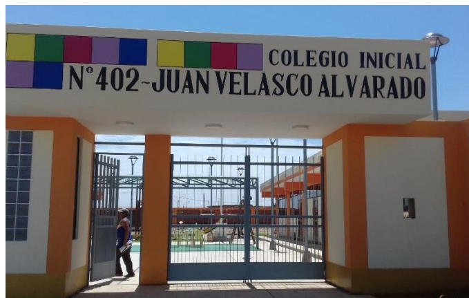
Foto N° 1 Muestra las puertas de ingreso terminadas, muros pintados y letras.
