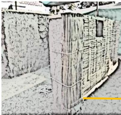
Uso de muro aislante Térmico, material de totora.
