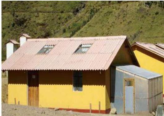
**IMAGEN 18:** foto de vivienda usando el muro trombe y a su vez el invernadero para acumular calor y transmitir la casa.
