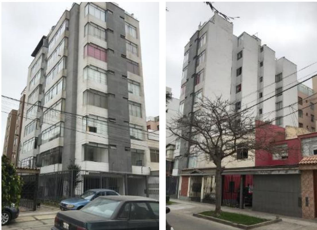
Gráfico N° 17: Vista de la edificación construida
