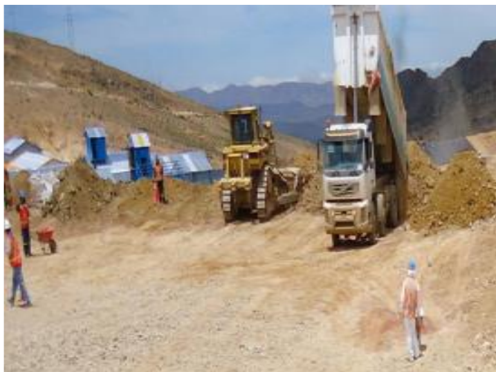
Figura 2. Descarga de mineral en el pad lixiviación
