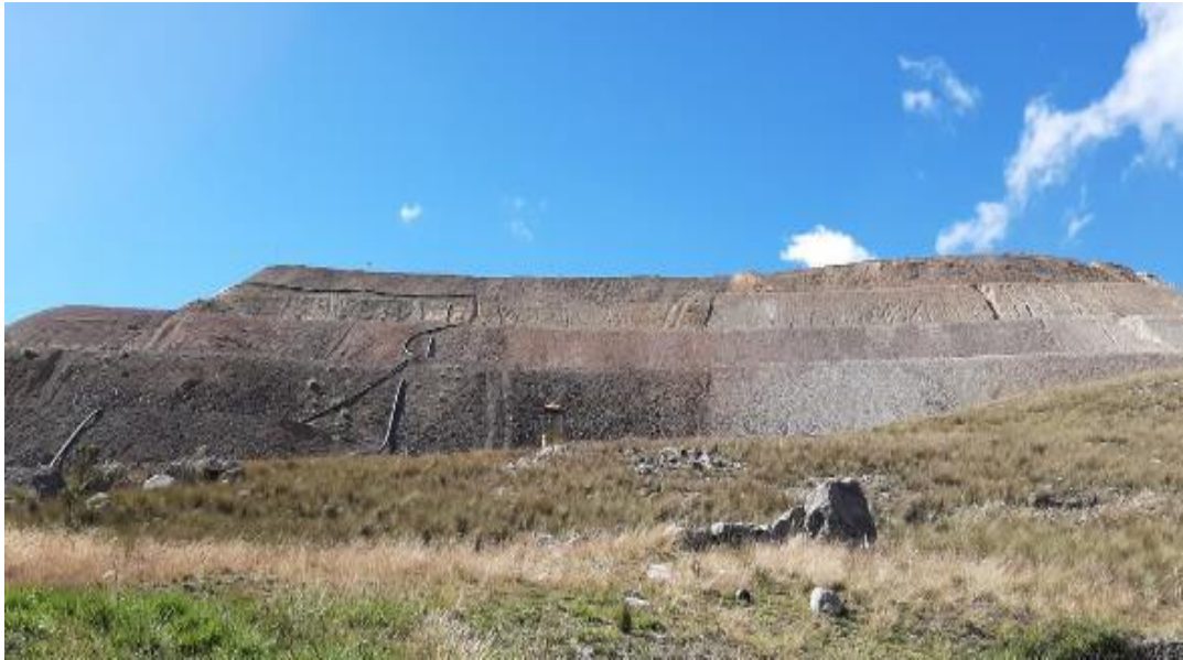
Foto 5. Cara Este del Pad Lixiviación de la Empresa Minera en estudio.
