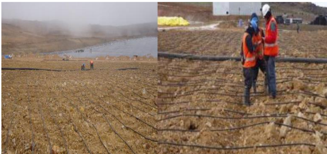
Figura 5. Instalación de riego con solución cianurada ( \text{NaCN} = 250 \text{ ppm} )
