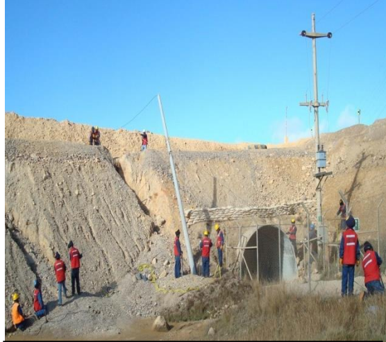
Izaje de poste manual donde no hay ingreso de grúa.
