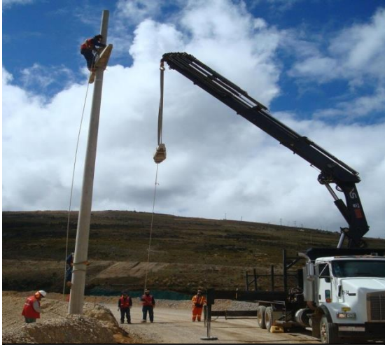
Izaje de poste y accesorios de red eléctrica aérea
