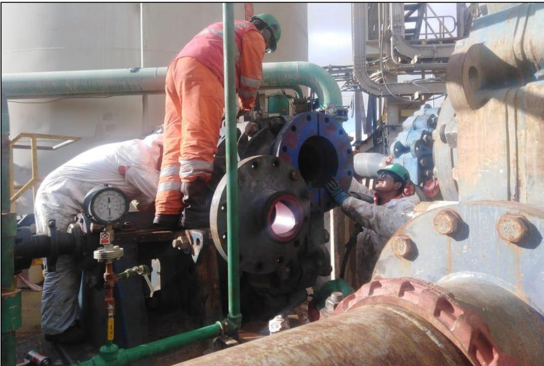
Figura 46. Actividad de cambio de componentes internos de caucho.
