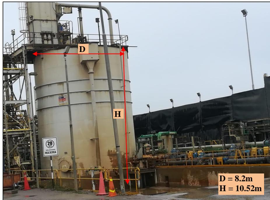
Figura 15. Medidas del tanque.
