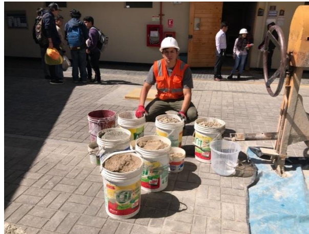
Figura 10. Materiales listos para la preparación del concreto.
