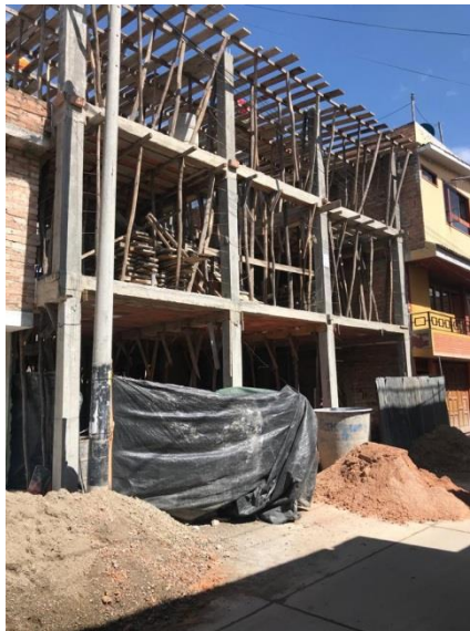
Figura 25. Obra de cajamarca.
