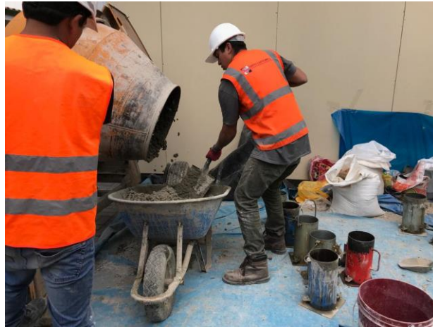
Figura 28. Elaboración del concreto.
