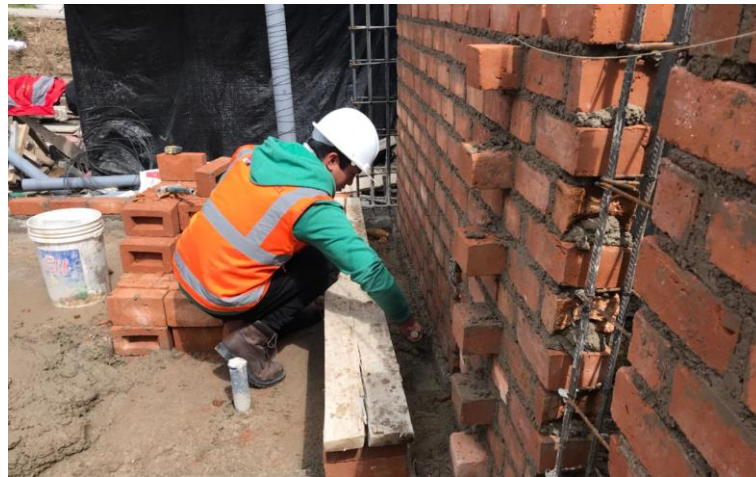
Figura 3. Recolección de desperdicio de mortero
