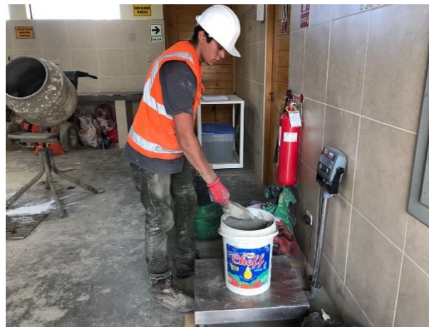
Figura 9. Pesaje de los agregados y el cemento.
