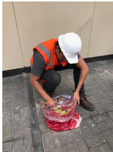
Figura 27. Trituración del mortero.
