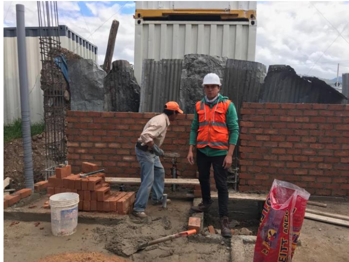
Figura 26. Obtención del desperdicio de mortero.
