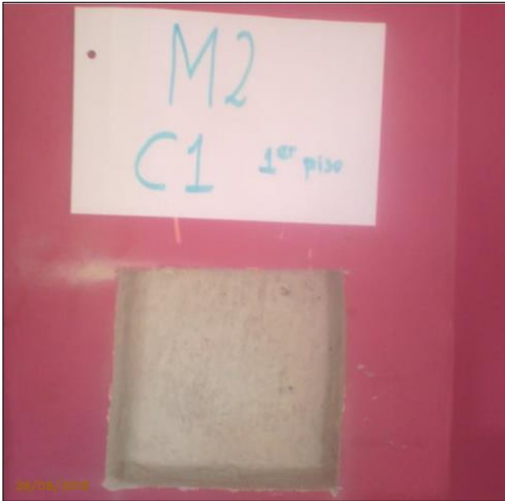
Figura 87. Superficie preparada para el ensayo, C1 1° piso-Módulo 02.
