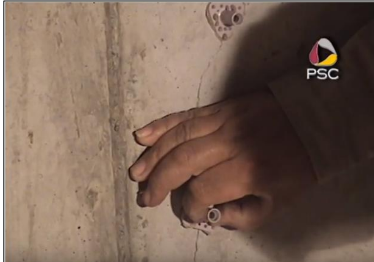
Figura 102. Colocación de boquillas. Incompsc, 2016.
