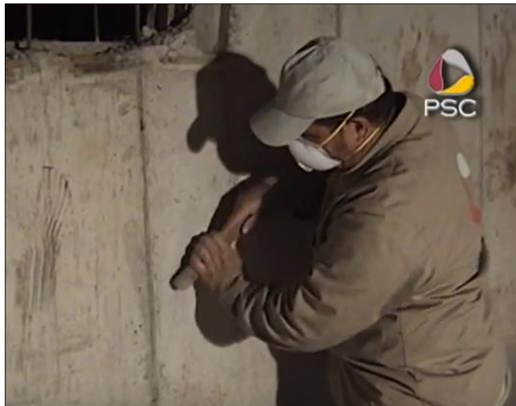
Figura 101. Proceso de limpieza con una escobilla de acero. Incompsc, 2016.
