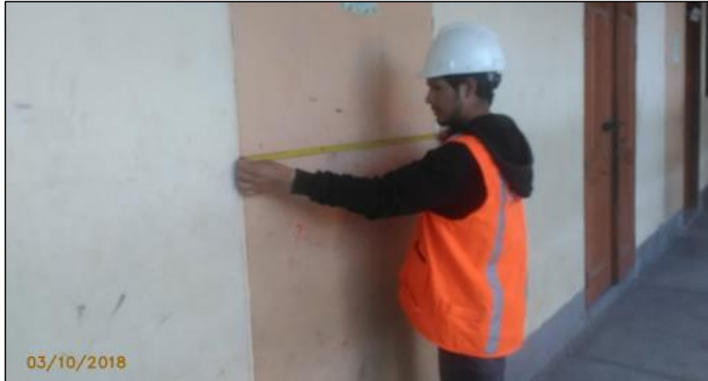
Figura 10. Tomando medidas de la columna C7 para su posterior verificación.
