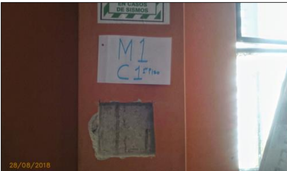
Figura 82. Superficie preparada para el ensayo, C1 1° piso-Módulo 01.
