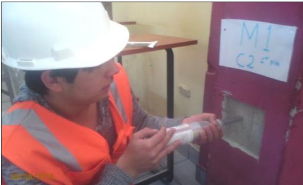
Figura 84. Realizando el ensayo en la C2 1° piso-Módulo 01.
