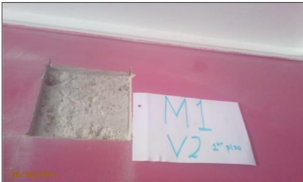
Figura 86. Superficie preparada para el ensayo, V2 1º piso-Módulo 01.
