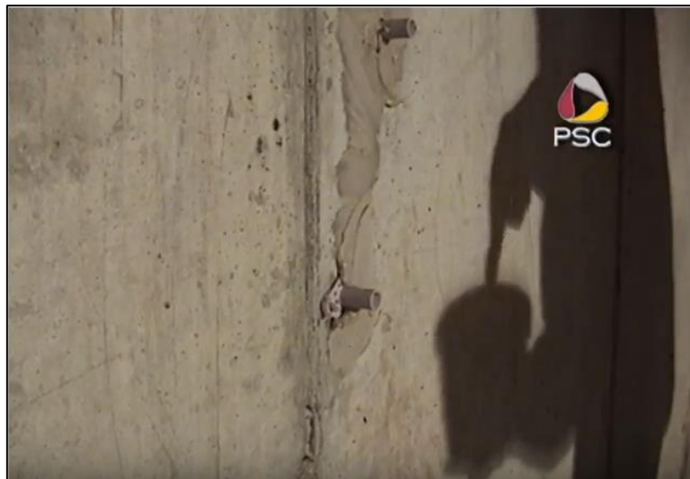
Figura 103. Sellado de boquillas. Incompsc (2016).
