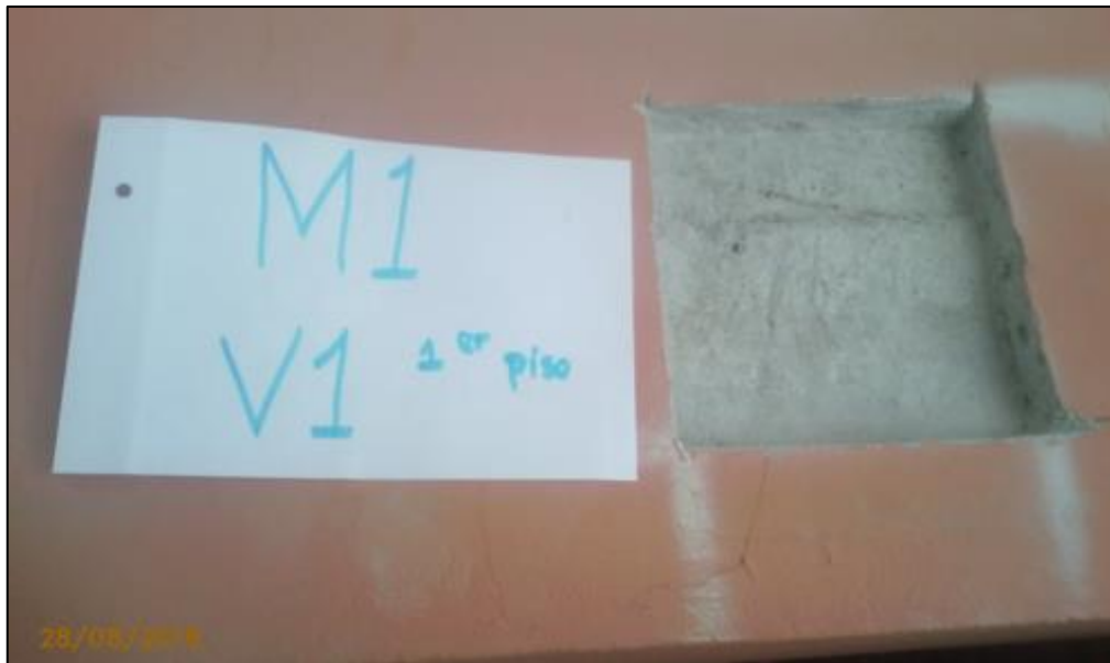
Figura 85. Superficie preparada para el ensayo, V1 1º piso-Módulo 01.
