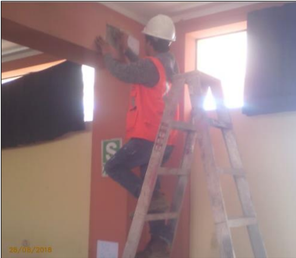
Figura 81. Realizando el lijado del punto donde se realizó el ensayo.
