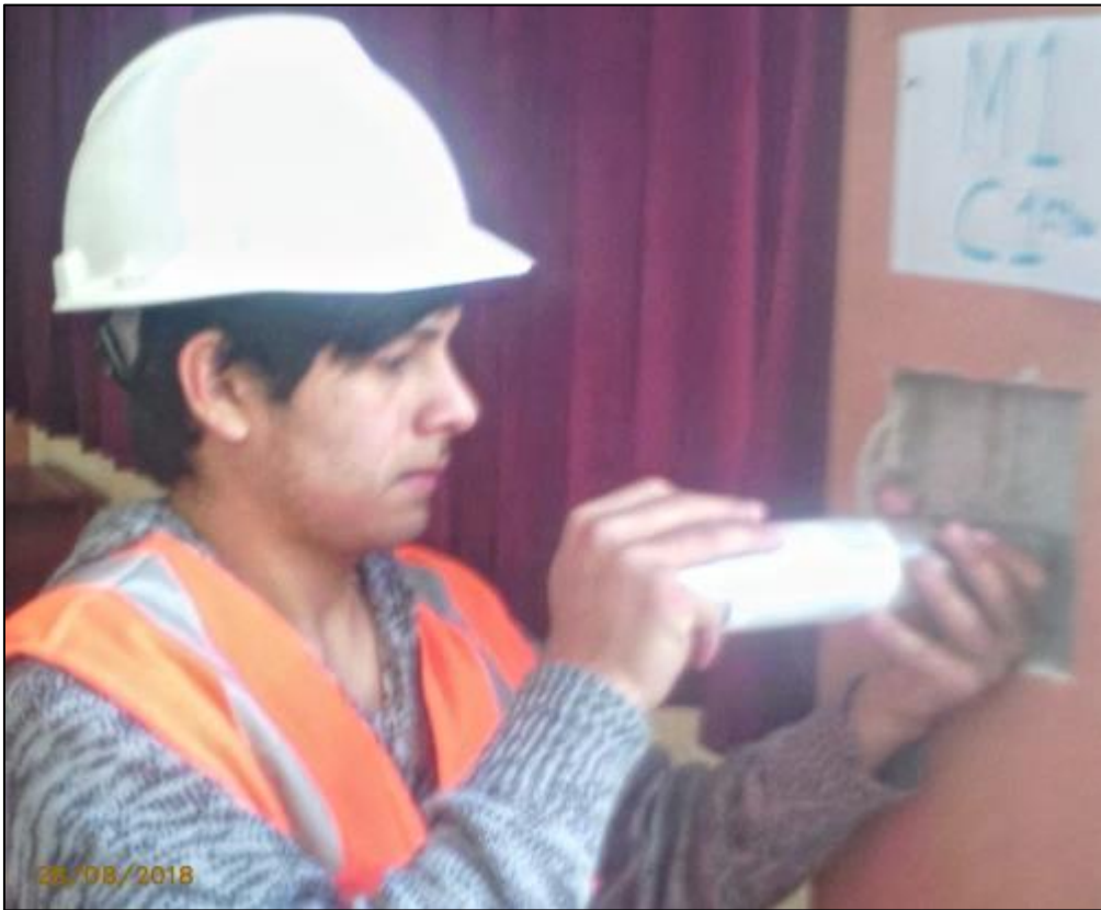
Figura 83. Realizando el ensayo en la C1 1° piso-Módulo 01.
