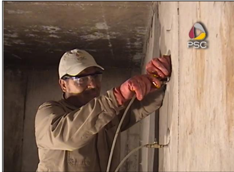
Figura 104. Inyección de la resina epóxicas. Incompssc, 2016.
