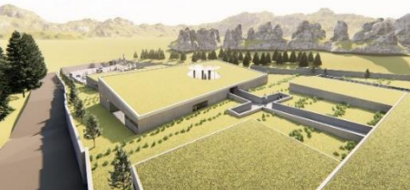
Figura N°3.24 Imagen de vista al módulo inferior. Adaptación al relieve del terreno, orientación hacia el sur.
