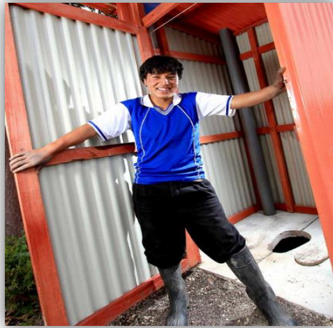
Figura N°37. Instalación de letrinas en el distrito de Cajamarca. Fuente: Minera Yanacocha
