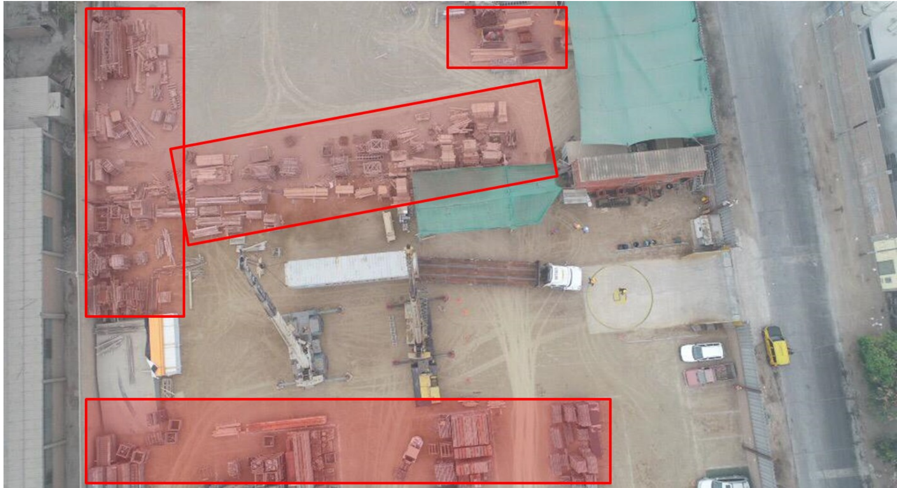
Figura N° 27: Vista Panorámica de Planta REM
