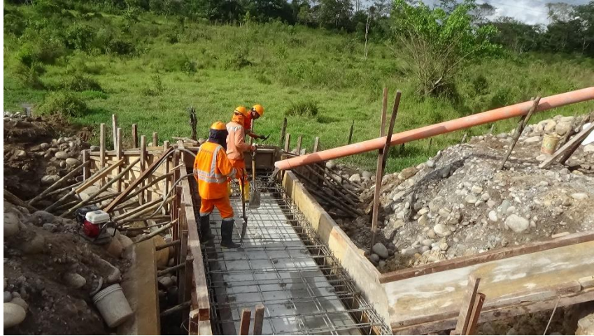
Figura n.º 21 Vaciado de aleros, muros laterales y losa superior de alcantarilla marco
