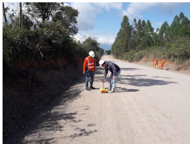
Figura n.º 4 Prueba de densidades con el densímetro nuclear
