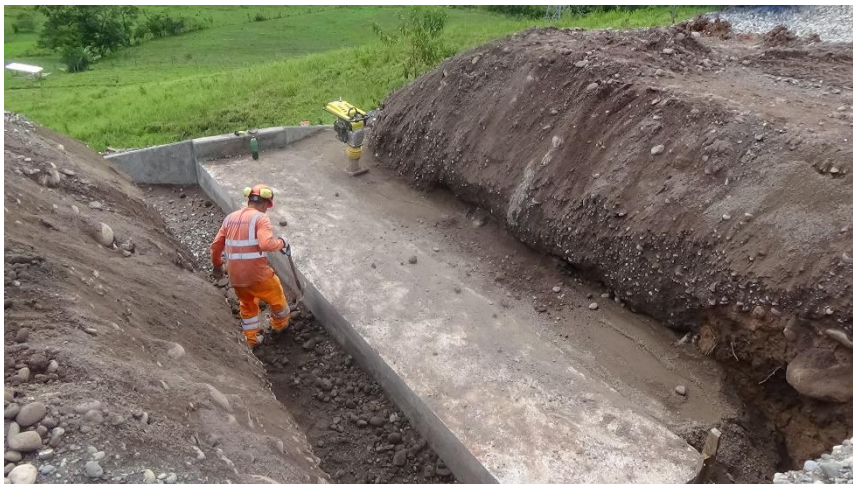
Figura n.º 22 Relleno de alcantarilla marco
