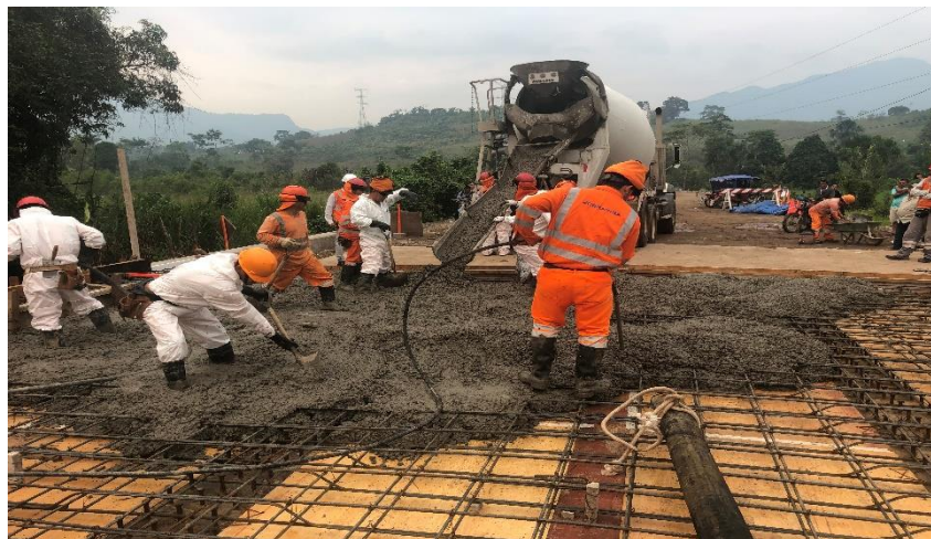
Figura n.º 25 Vibrado de concreto
