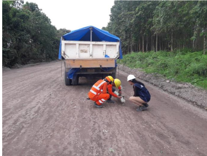
Figura n.º 5. Prueba de deflectometría con la viga Benkelman
