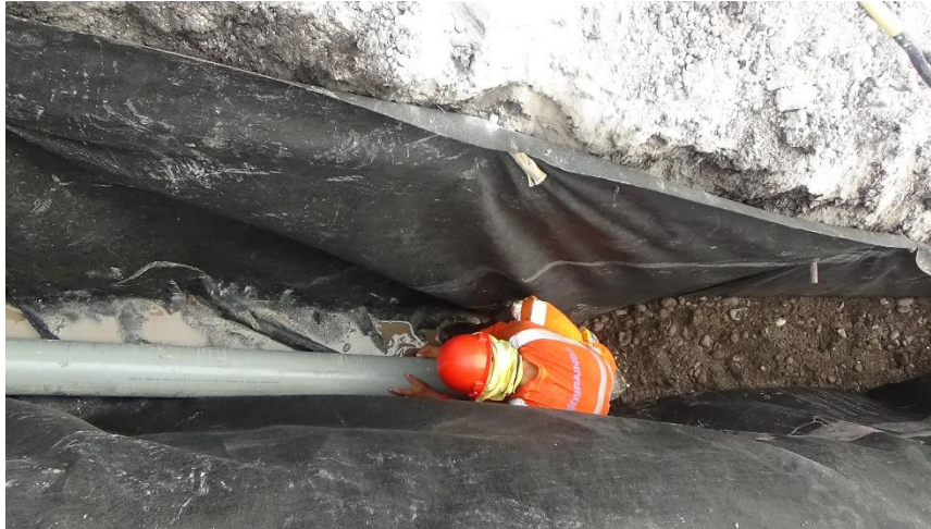
Figura n.º 19 Colocación de tubería de Subdren profundo
