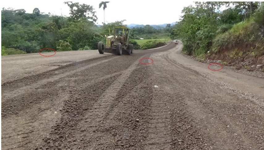
Figura n.º 17 Plantillas en conformación de Sub-rasante, Sub-base y Base
