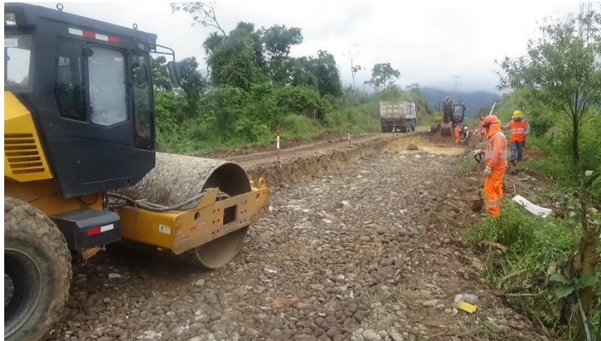
Figura n.º 16 Excavación y compactación de over en mejoramiento de suelos
