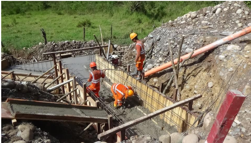
Figura n.º 20 Vaciado de losa inferior alcantarilla marco
