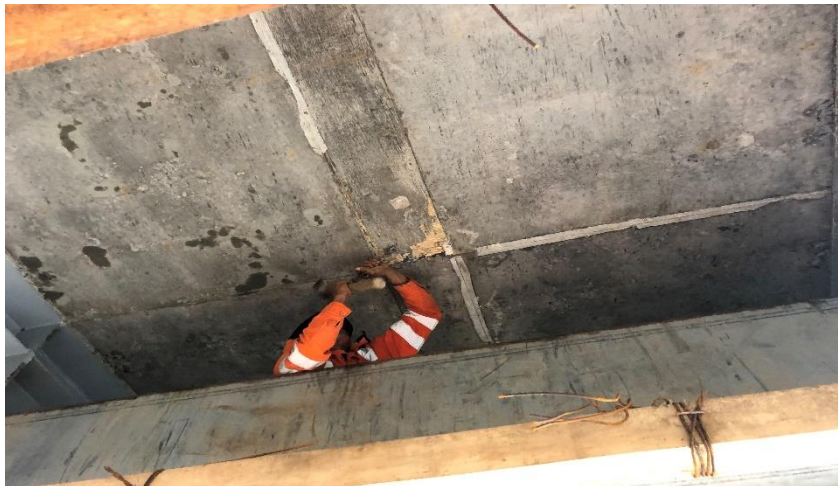
Figura n.º 26 Reparación de concreto cara vista por mal uso de desmoldante en el encofrado
