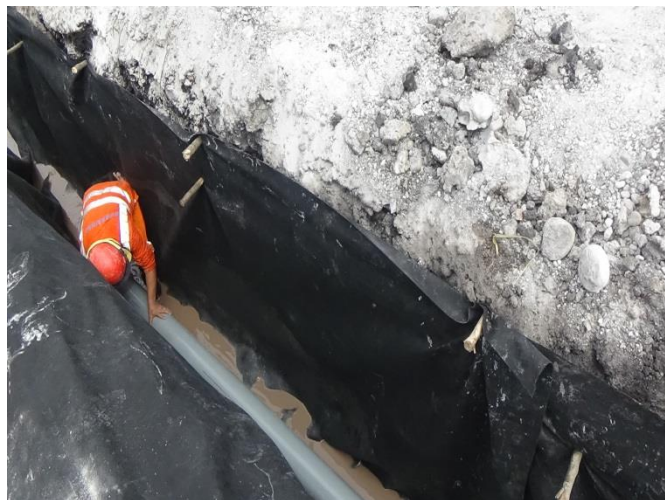
Figura n.º 8. Correcta colocación de tubería de Subdren
