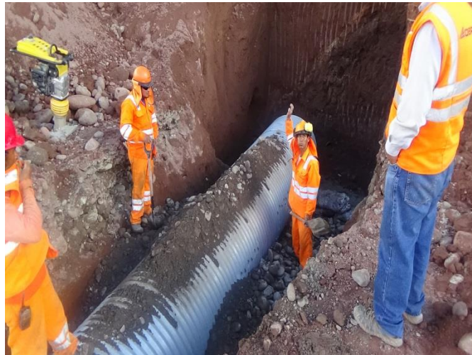
Figura n.º 7 Colocación de tubería sobre terreno mejorado
