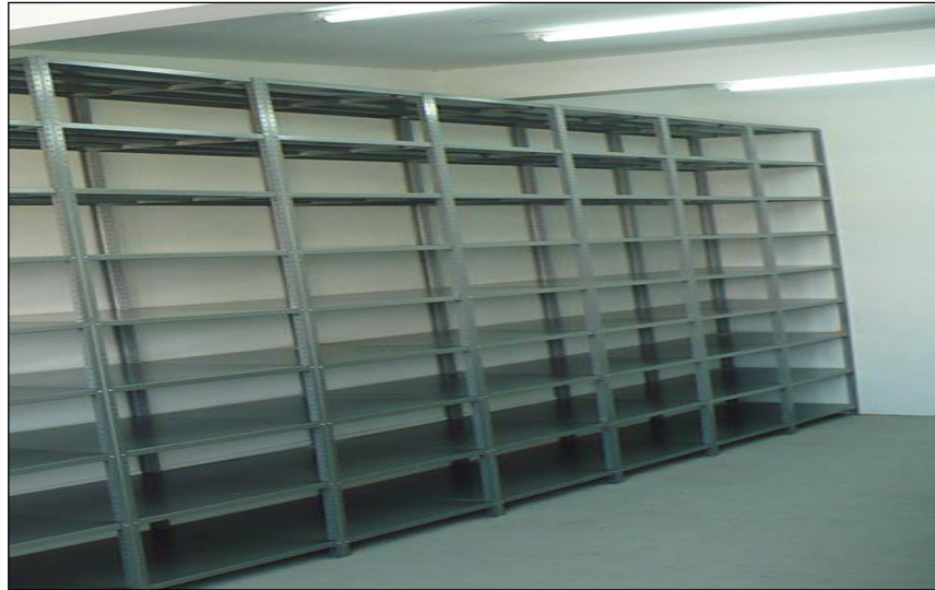
Figura 8: Estantes metálicos para almacenar los materiales
