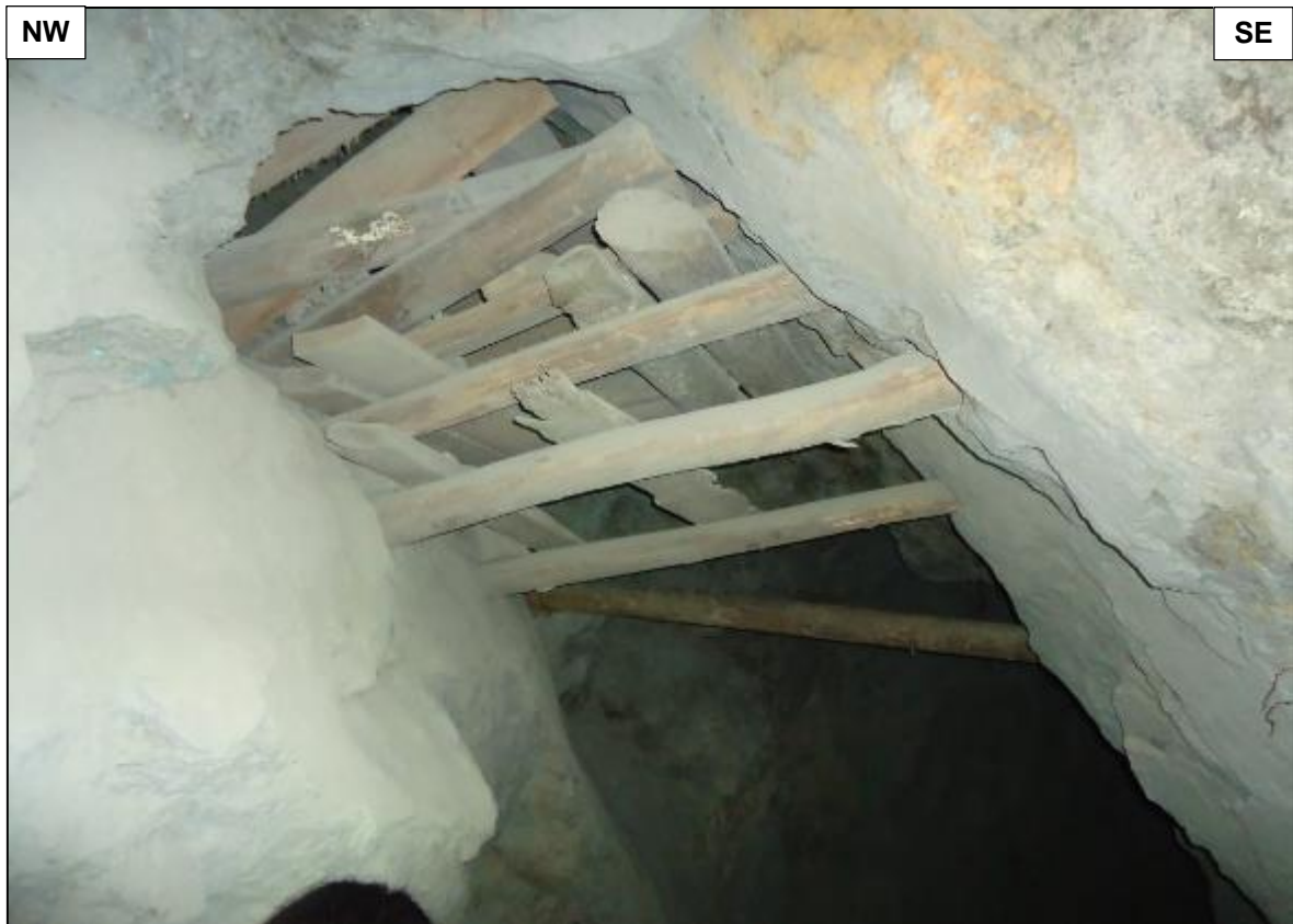
Figura 15. Chimenea en los socavones de San Luis 2019.
