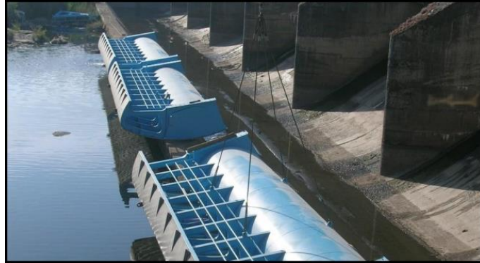
Figura N° 2: Compuertas radiales
