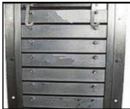
Figura N°3: Compuerta de ataguía
