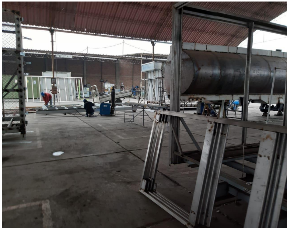
Figura 47. Condiciones Óptimas del área de armado
