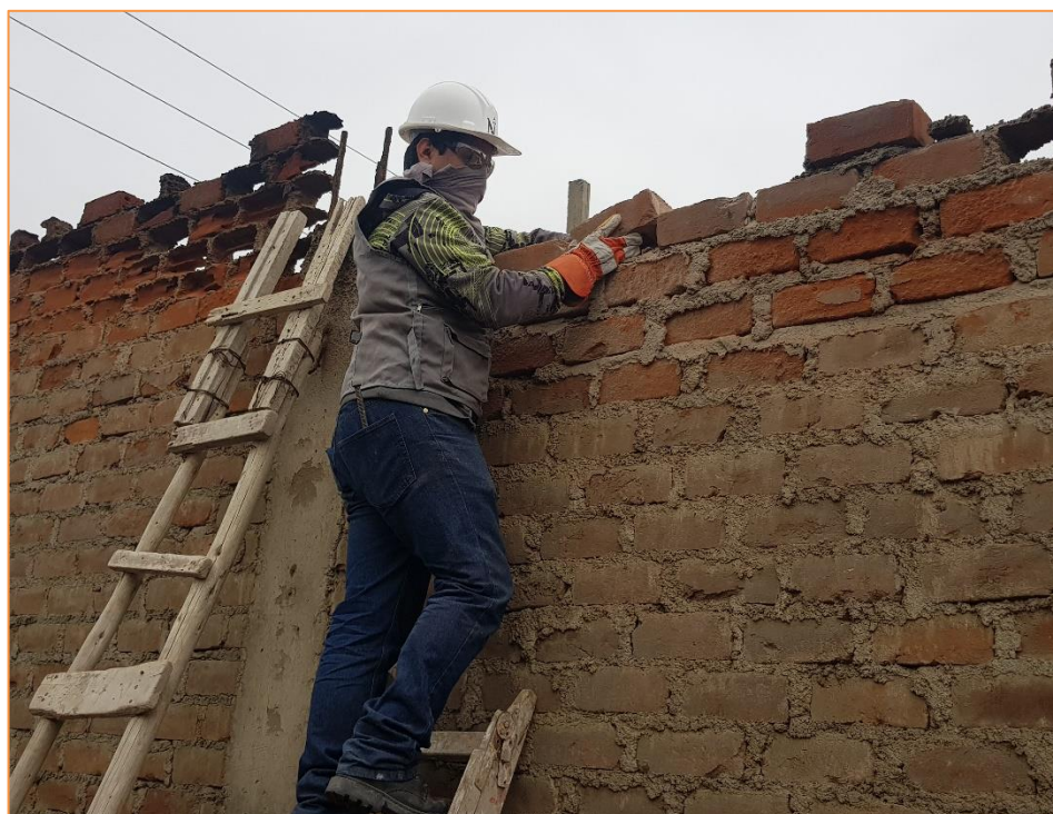
Figura 28. Extracción de unidades de albañilería en la Vivienda N° 03.
