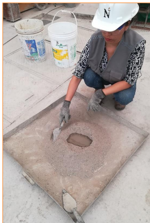
Figura 50. Elaboración de mortero.
