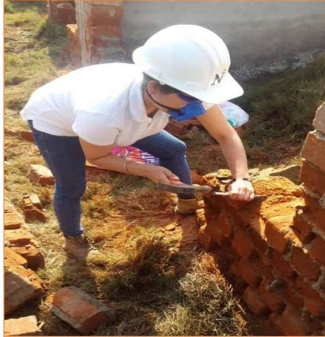
Figura 21. Extracción de muestras de la Vivienda N° 02. Fuente: Elaboración propia, 2019.
