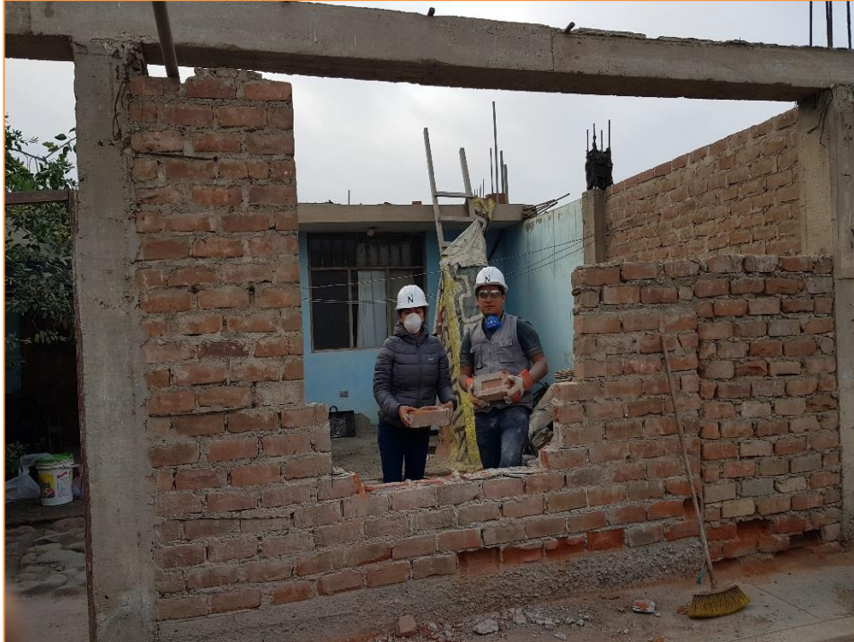
Figura 25. Unidades de albañilería extraídas.
