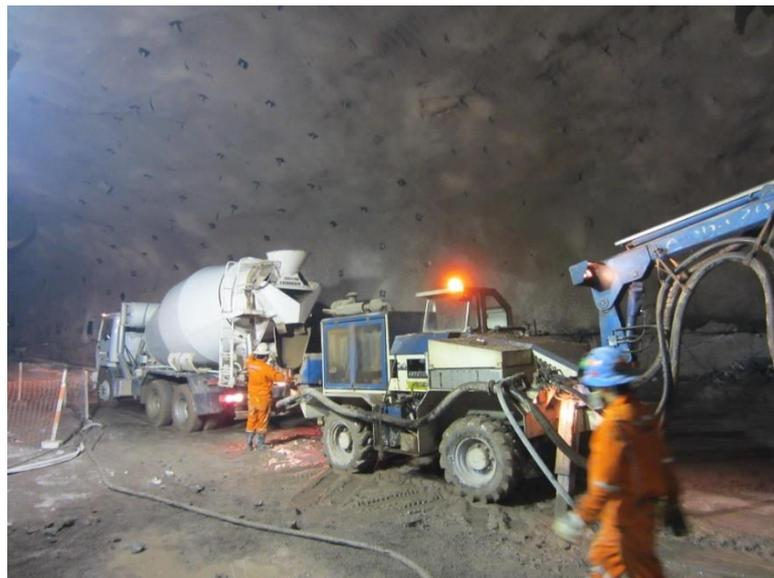
*Figura n °2.10. Lanzado de shotcrete*
