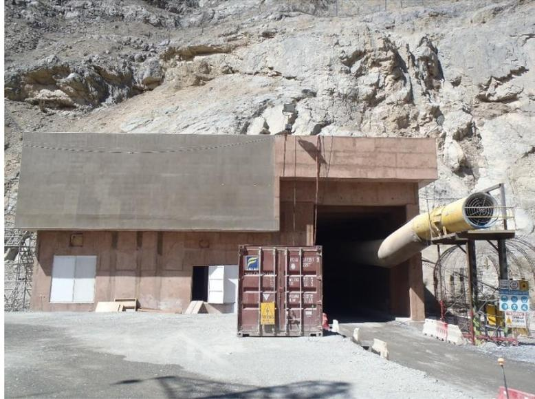
*Figura n °2.8. Ventilación*
