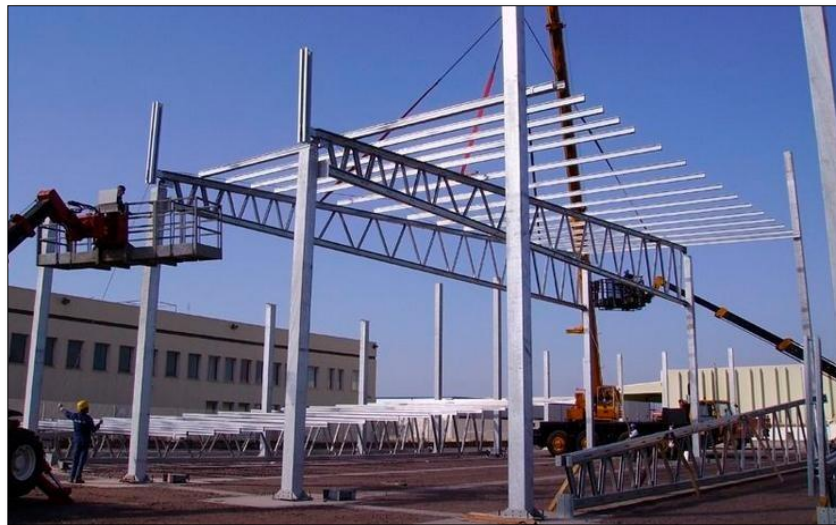
Figura 12. Montaje de una viga de celosía para conformación del pórtico estructural.
