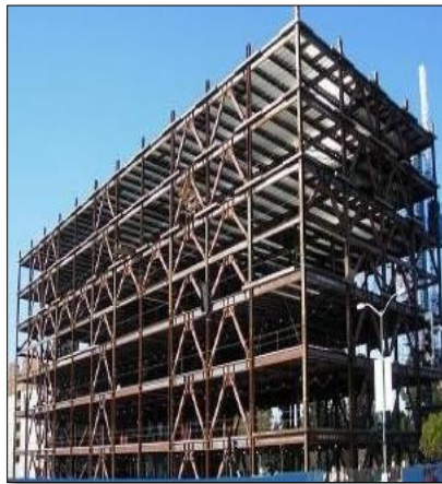
Figura 22. Vista de un edificio en construcción con pórticos arriostrados.
