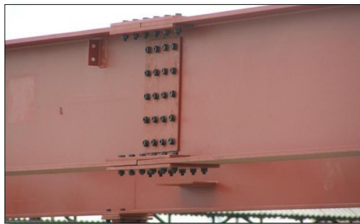
Figura 15. Conexión atornillada entre dos vigas principales.
