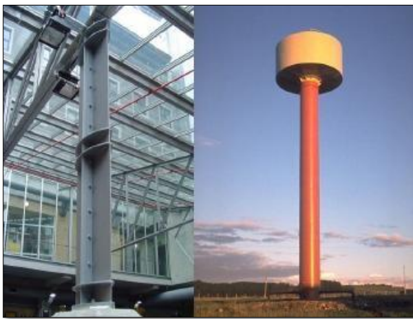
Figura 25. Ejemplos del sistema estructural columna en voladizo.
