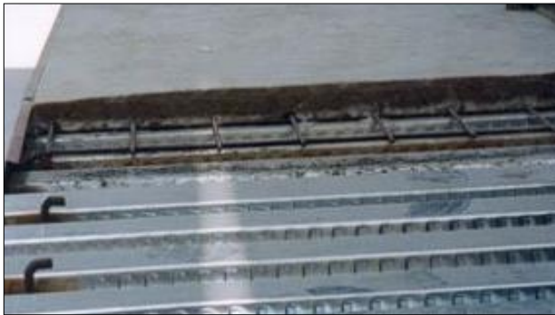
Figura 17. Entrepiso metálico con láminas colaborante.
