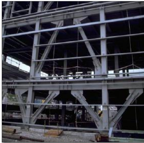
Figura 23. Construcción de un edificio de acero con pórticos arriostrados excéntricamente
