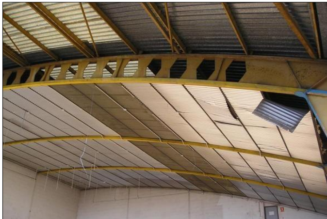
Figura 11. Pórtico principal de un galpón metálico conformado por una viga aligerada en forma de arco
