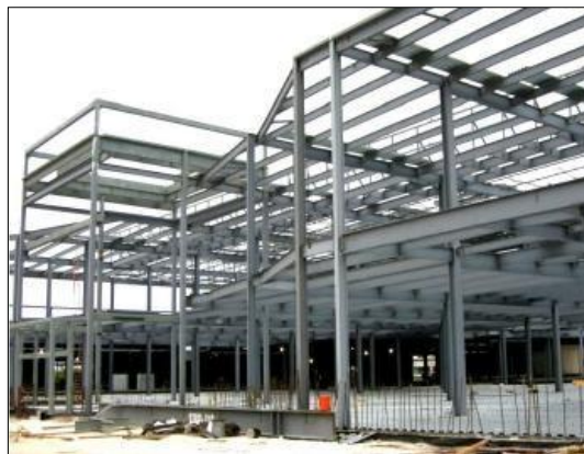
Figura 20. Vista general de una estructura de pórticos no arriostrados para un edificio comercial.
