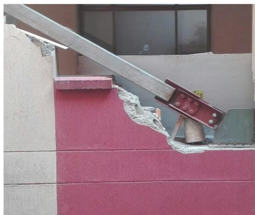
Figura 27 Hospital de Florencia, Caquetá, Colombia Fuente: Quaketek
