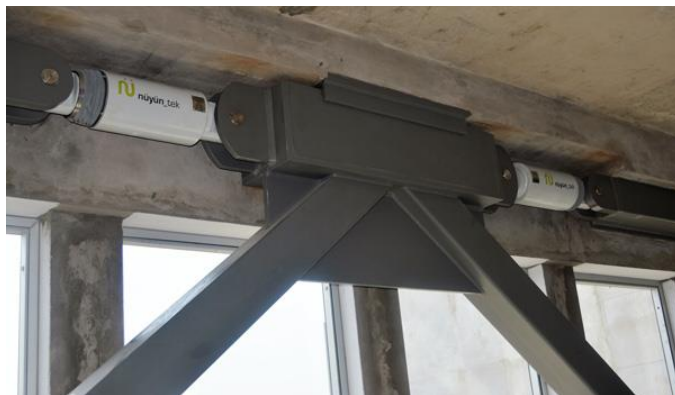
Figura 5 Disipador de fluido viscoso. Fuente: CDV
