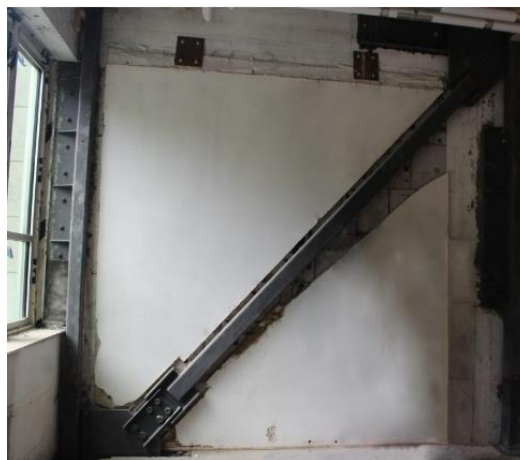
Figura 3 Disipador de fricción Fuente: Disipadores Quaketek
