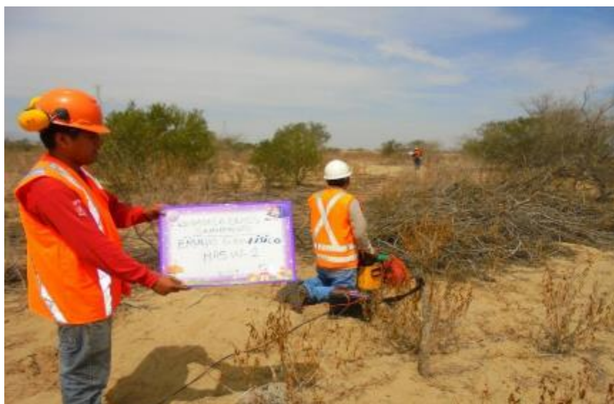
Foto 2. Ensayo MASW - 02 en planta de tratamiento de agua Residual PTAR.
