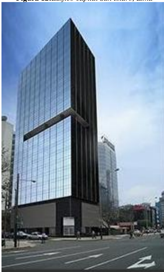
Figura 12: Edificio capital San Isidro, Lima
