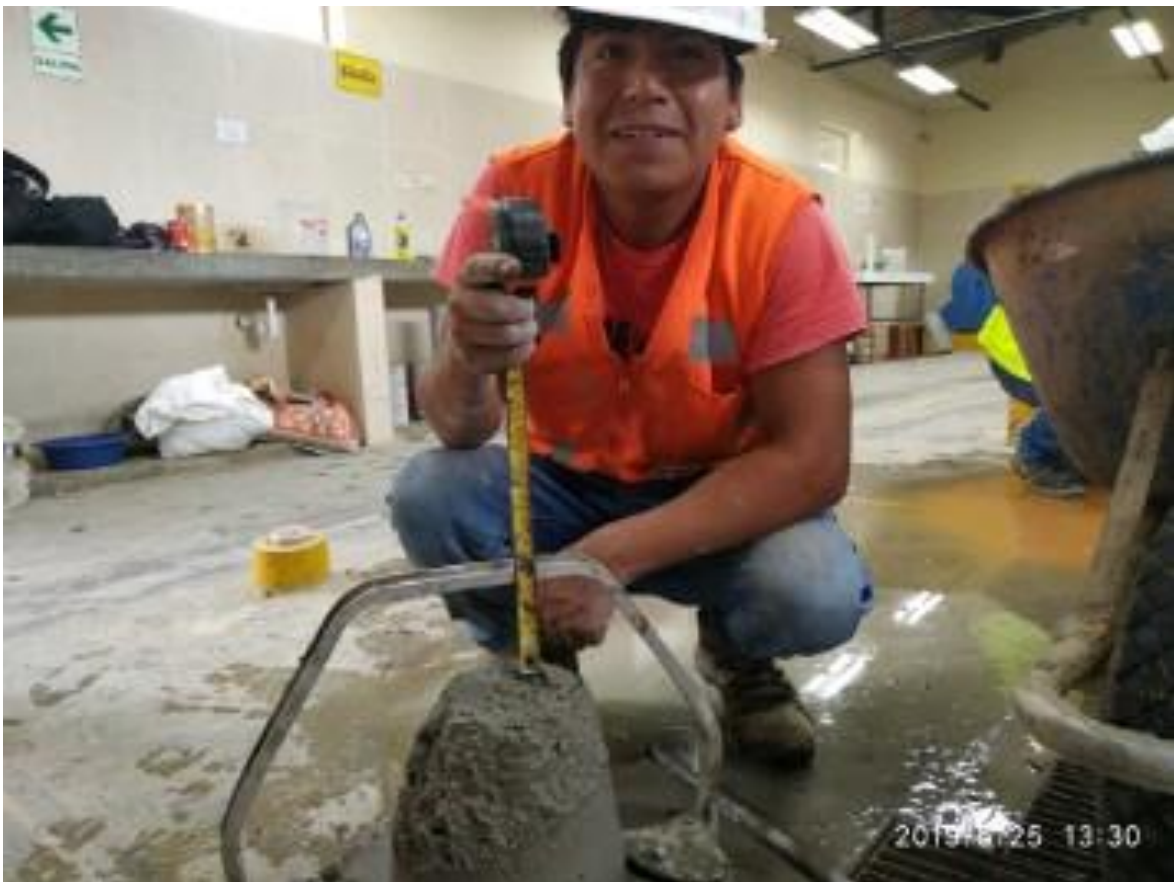
ILUSTRACIÓN 07: Ensayo de asentamiento del concreto fresco
