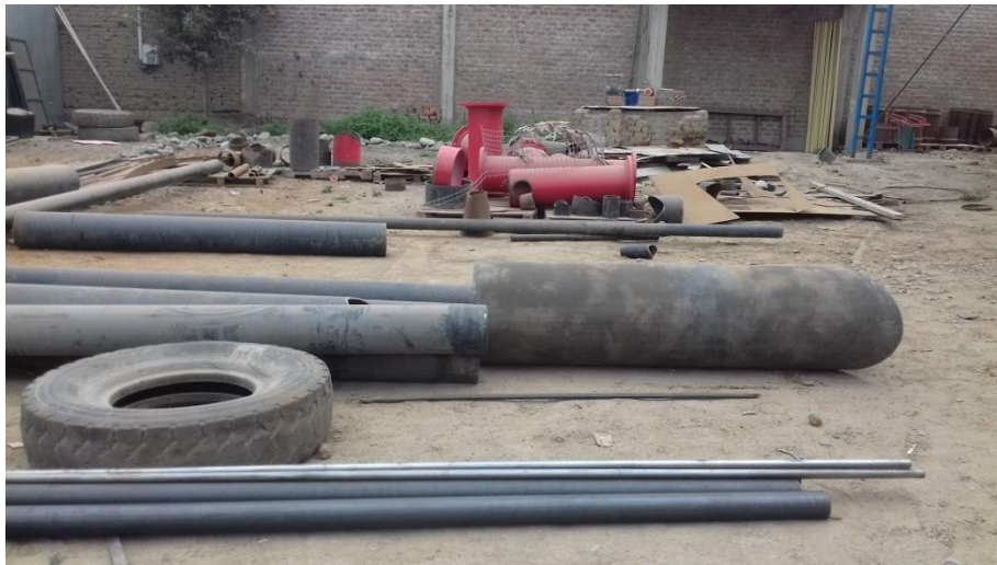
Área de armado
