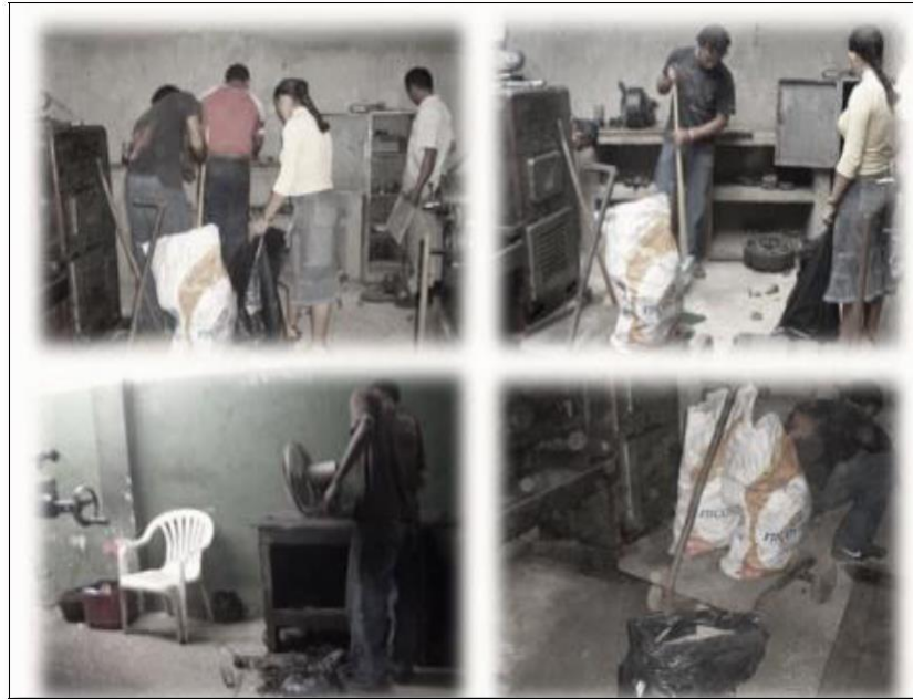
Figura 19. Ejecución del plan de limpieza
