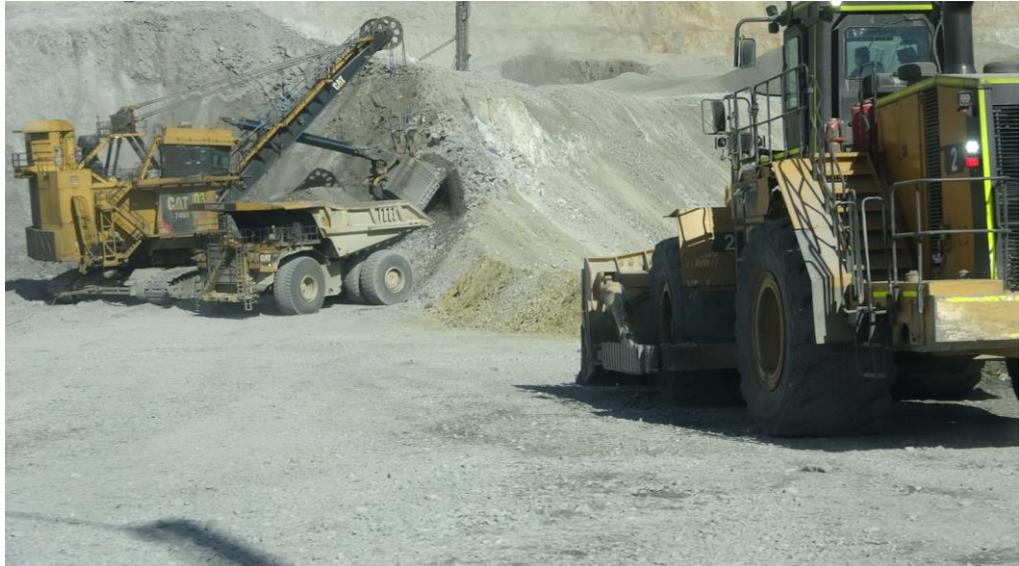
*Figura 32: Desnivel del piso en zona de carguío. Tractor de ruedas en trabajo de nivelación.*
