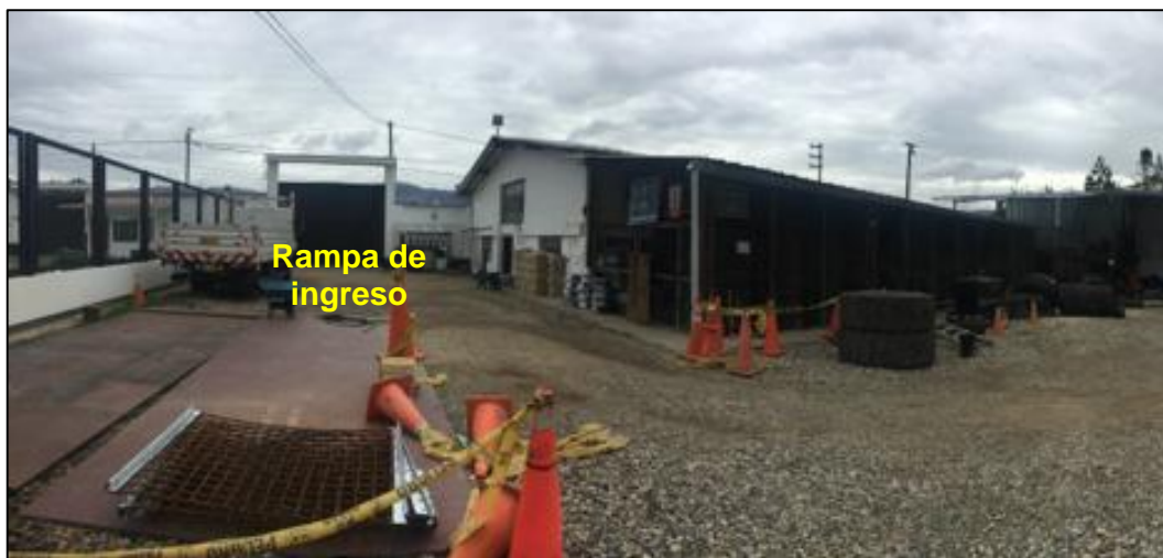
Figura 18. Área de acumulación de llantas en desuso.
