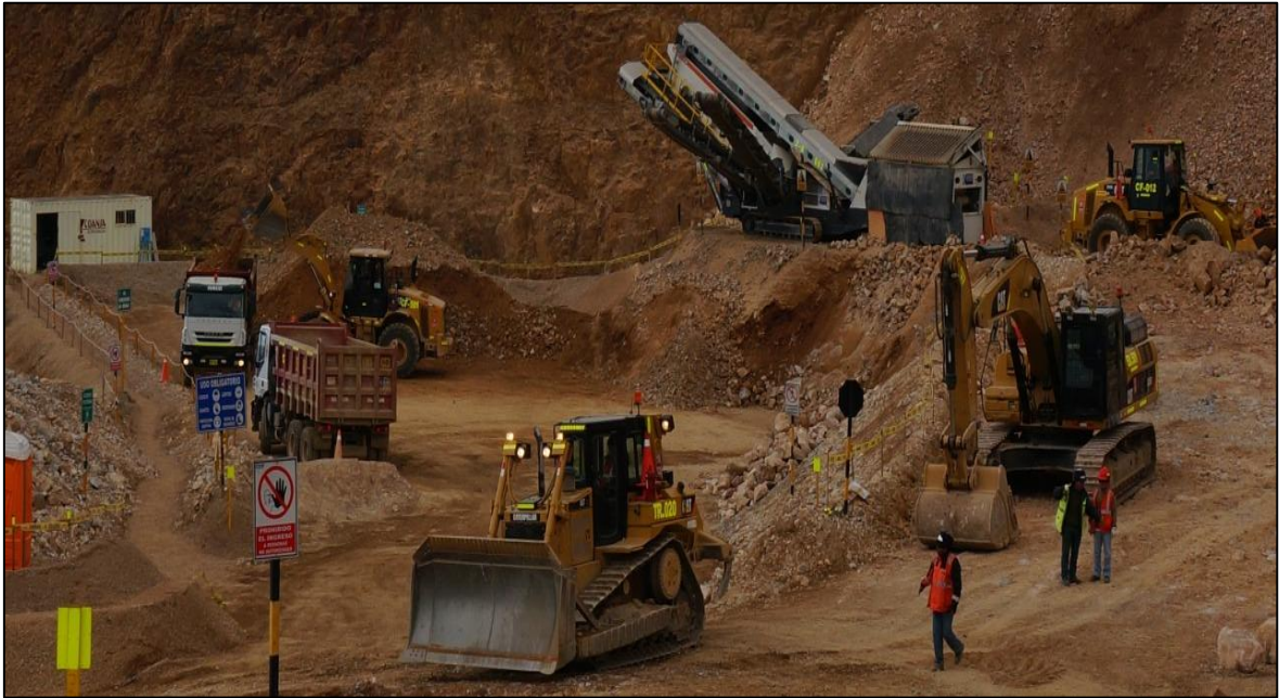
Figura 43. Equipos de la empresa en operación.
