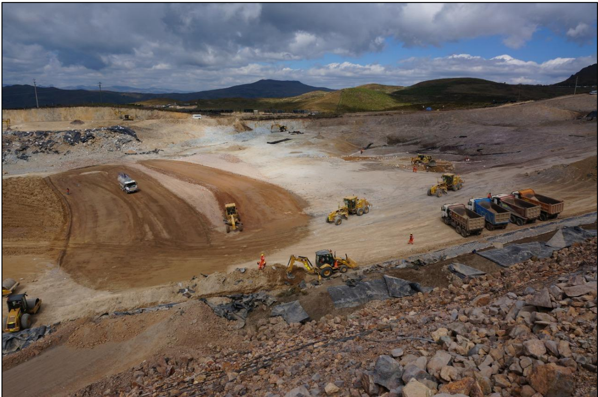
Figura 44. Actividades de carguío y acarreo por equipos.
