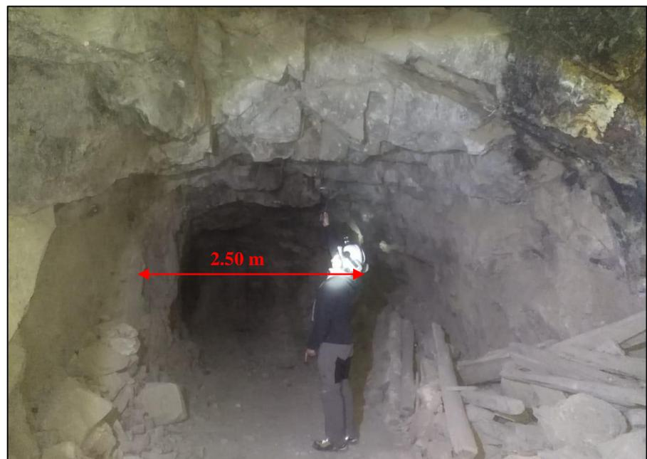
Figura 40. Ancho de la labor.
