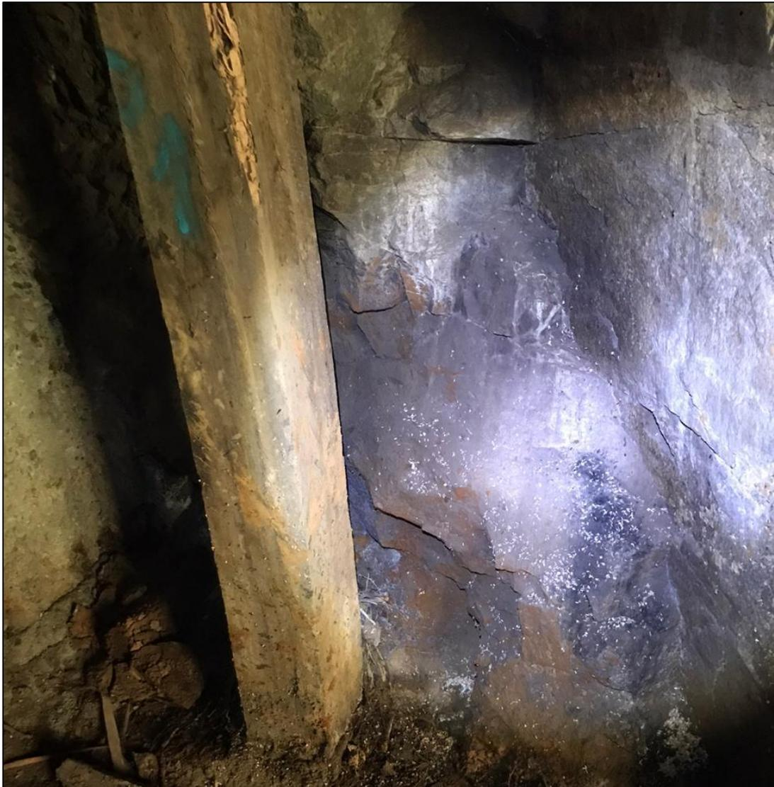
**Figura 37:** Sostenimiento con madera actual (deteriorada) en el nivel 05.
