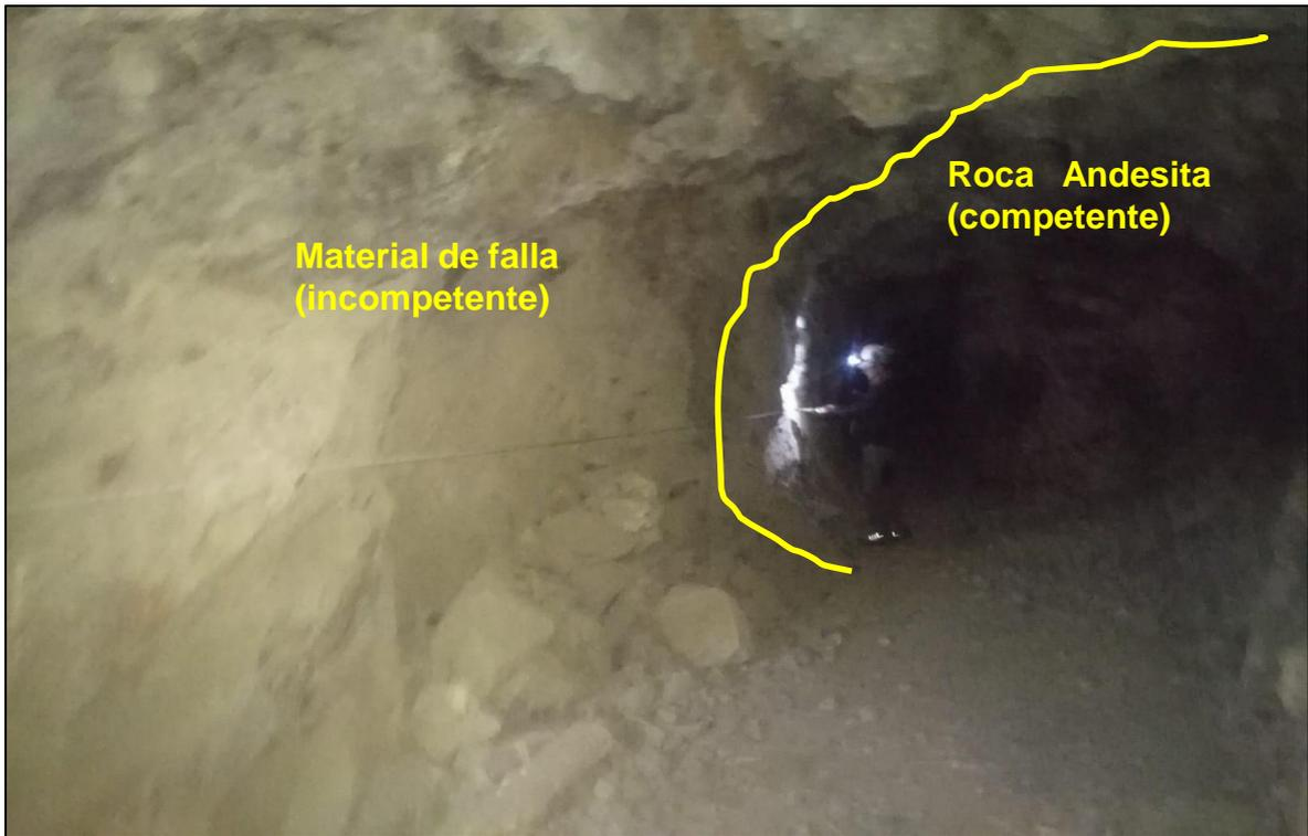
Figura 11. Presencia de material suelto en falla geológica (zona crítica 3).
