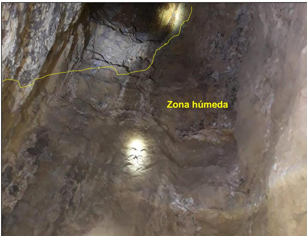
Figura 26. Evidencia de la presencia de humedad en la labor.
