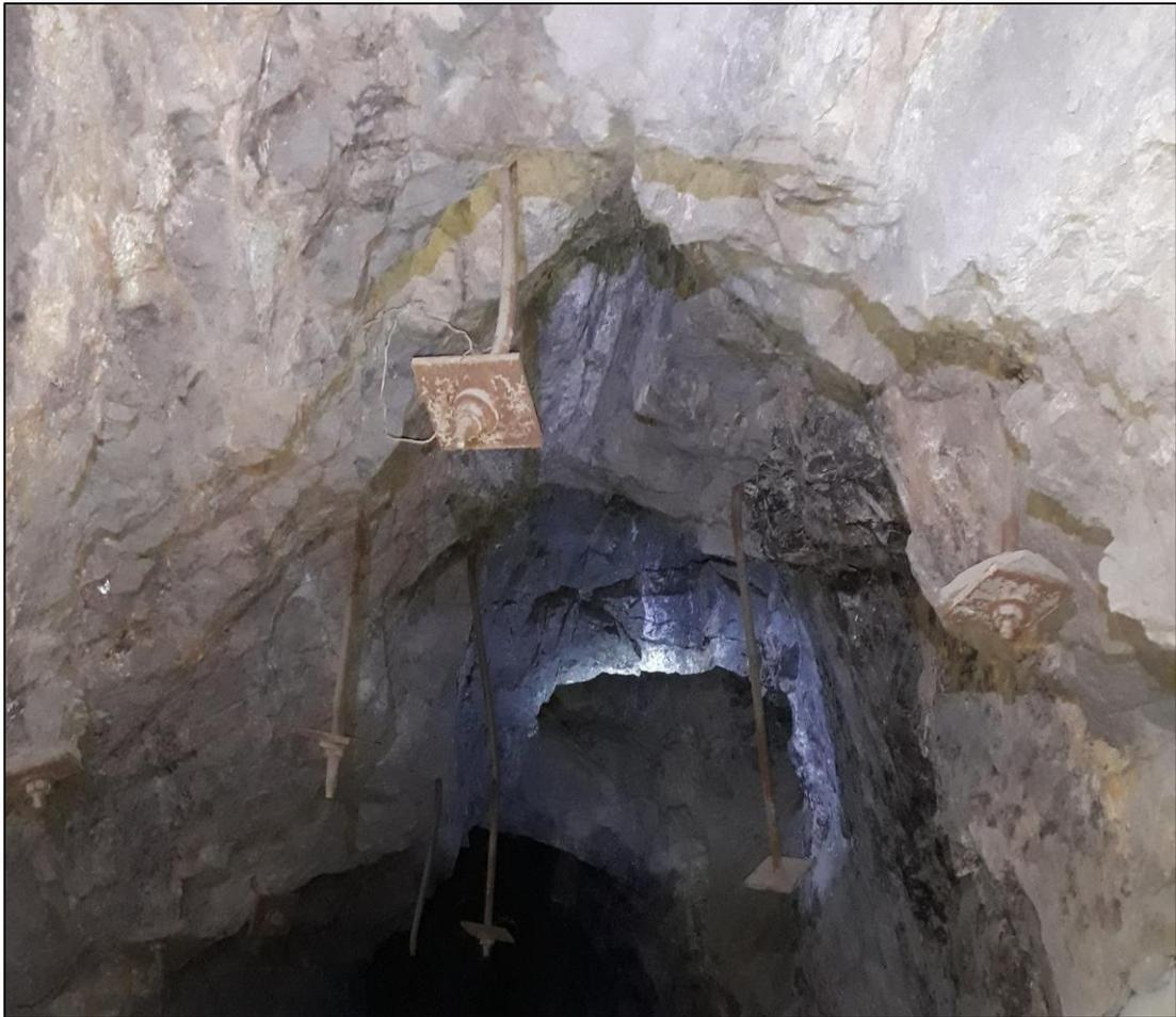
**Figura 39:** Bulonado deteriorado para cambiar.
