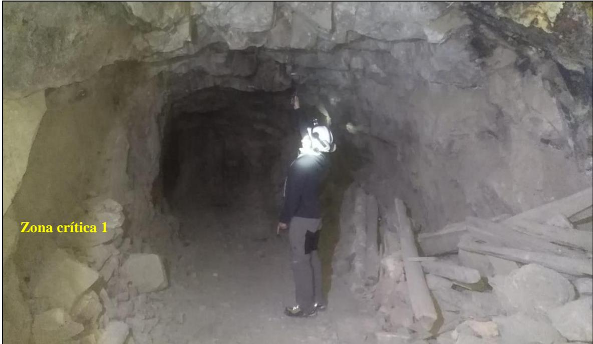
Figura 9. Presencia de material suelto en falla geológica (zona crítica 1).
