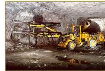
Figura 1. Perforación en frente, Método TOP HAMMER.
