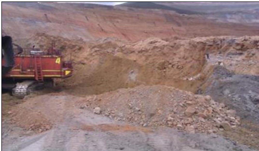
Ilustración 4: Colocación de Material de Lastre en los pisos de carguío.
