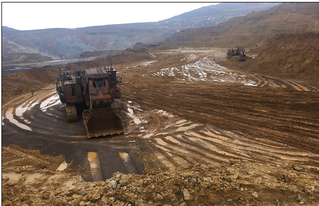
Ilustración 3: Operaciones en Suelo inestable y saturado-Temporada Húmeda (lluvia)
